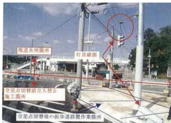
県警歩道用信号機灯具(未共用)破損
