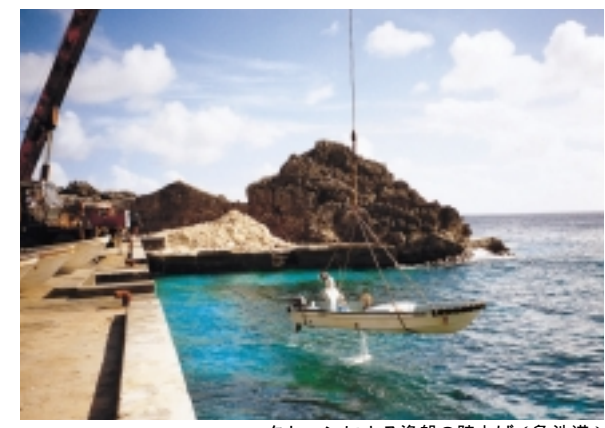
クレーンによる漁船の陸上げ（亀池港）
