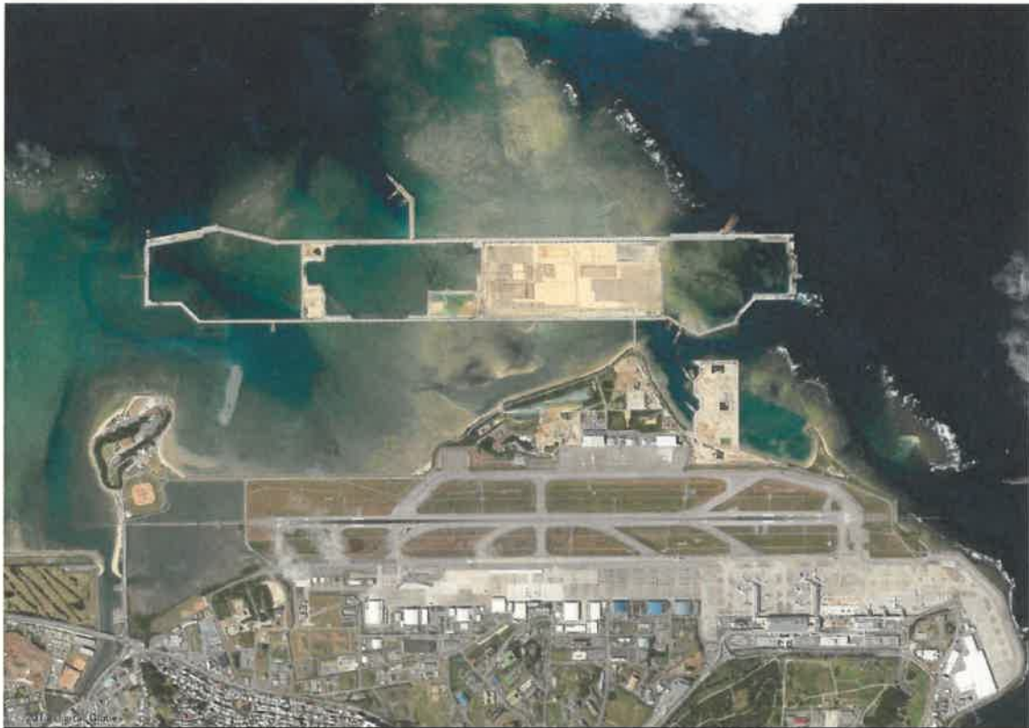
那覇空港の現況写真 (平成29年1月25日撮影)
