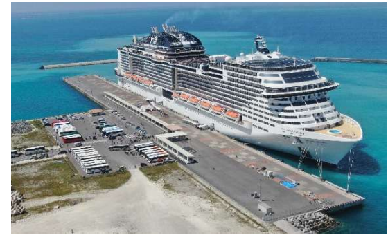
石垣港新港地区旅客船ターミナル
