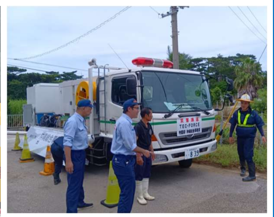
排水ポンプ車による応急復旧
