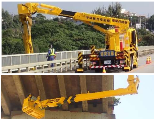
橋梁点検車による橋梁点検
