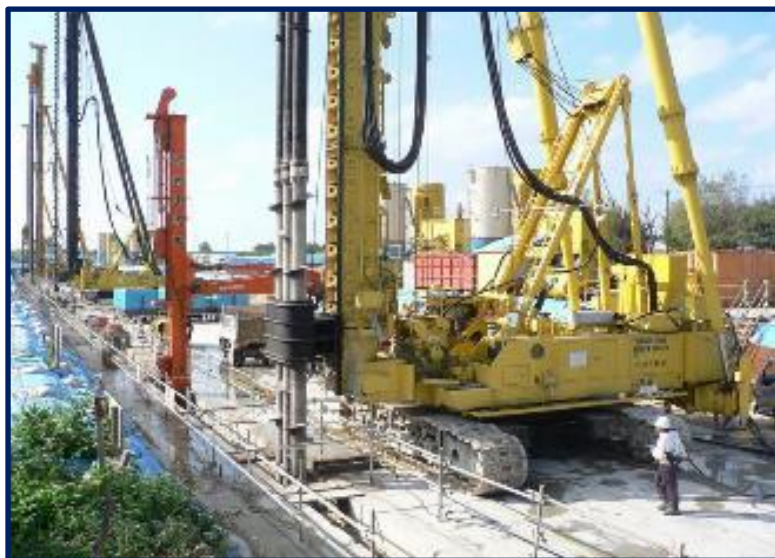
地下ダム施工状況
