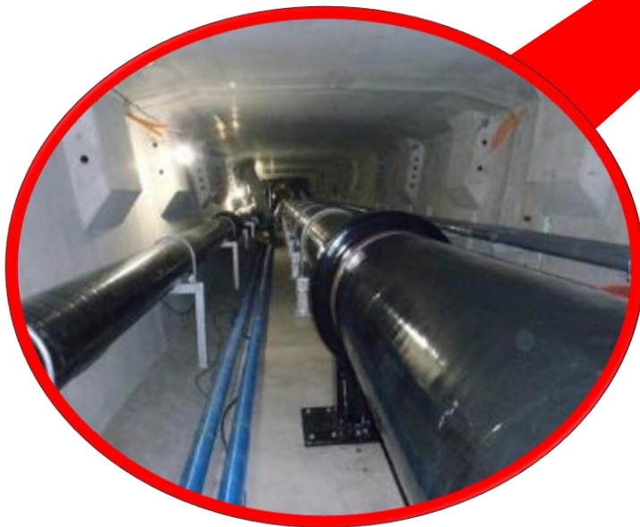
伊良部(いらぶ)島の畑地へ農業用水を供給するため、伊良部大橋の橋桁内部に用水管φ800mmを設置
