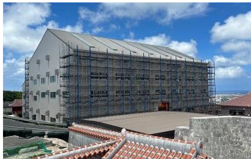
正殿 素屋根東側壁面グラフィック施工中 (R5 8/30) ※シャッターまわり施工中
