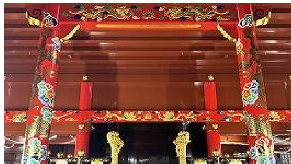
正殿 塗装工事 御差床2F 高蘭龍柱取付完了 (R8 6/18)
