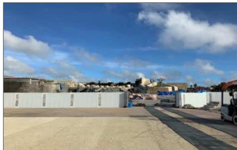
黄金御殿・寄満 解体完了 (R2 6/3)
