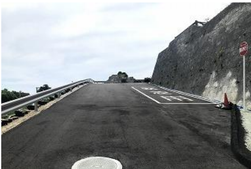
工事用仮設道路(ガードマンBOX前) 施工完了(R3 4/27)
