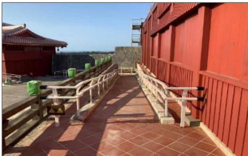
奉神門 応急対策 作業完了 (R2 3/17)
