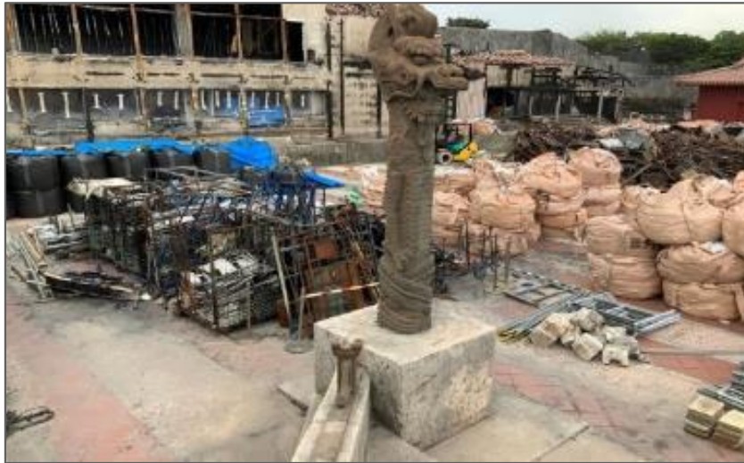
大龍柱 応急処置着手前 (R2 2/27)
