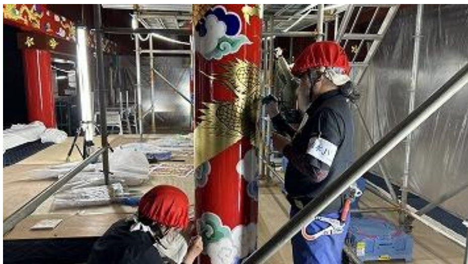
正殿 塗装工事 御差床2F 金龍五色之雲上塗り中 (R8 2/16)
