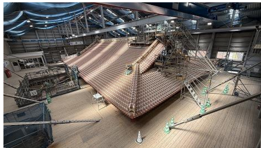
正殿 屋根工事 上層(龍頭棟飾り施工中) 点検通路 南西側から北東側望む (R7 6/25)
