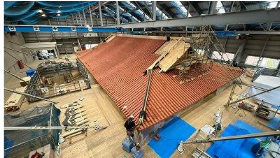
正殿 屋根工事 上層屋根(平・丸瓦葺き施工中) 点検通路 南西側から北東側望む (R6 7/31)
