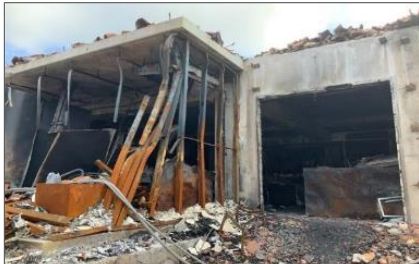
二階御殿 解体着手前 (R2 1/11)
