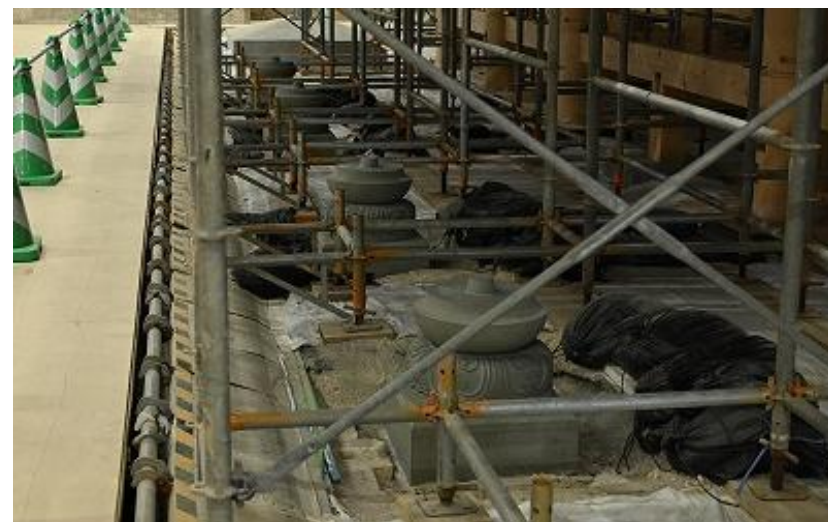
正殿 向拝礎盤据付 （R5 11/21）
