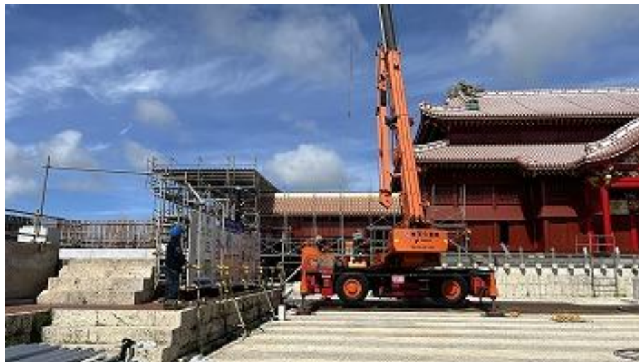
正殿 西之廊下 外部足場解体中 (R8 6/30)
