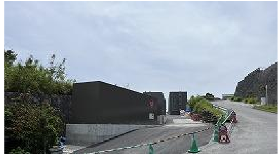
ゲートボックス(東)側より望む 防火水槽舗装完了後 (R8 5/1)
