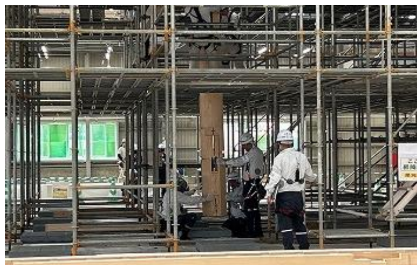
正殿木軸建方 下層柱建方1本目吊下げ中 1F 北側から南側望む (R5 9/4)
