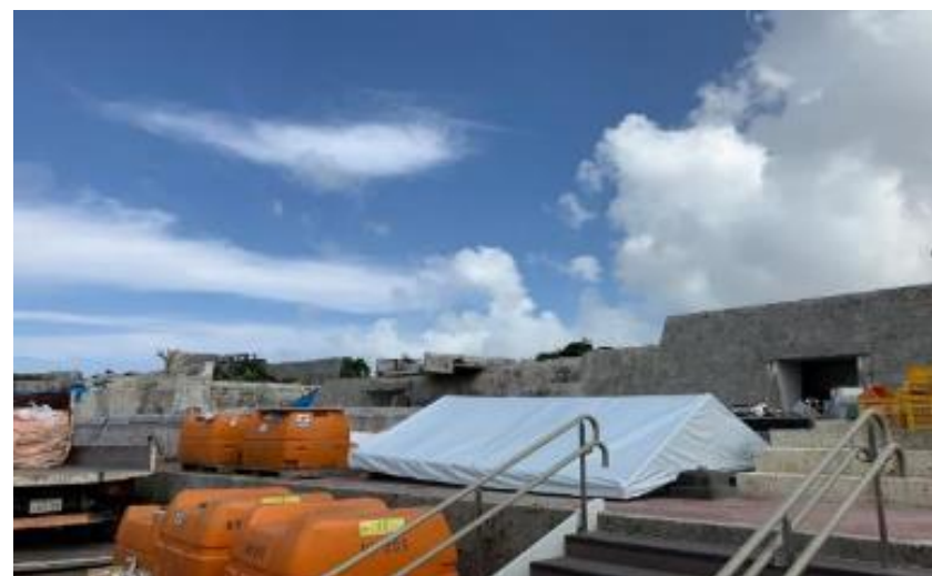
南殿・番所 解体完了 (R2 7/31)
