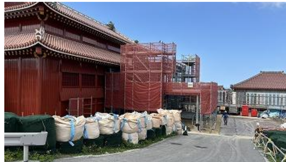
正殿 仮設階段棟 腰壁型枠中 (R8 2/26)
