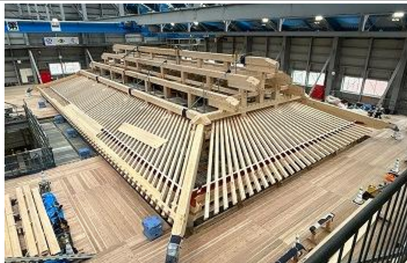
正殿 木工事 上層(地垂木等建込中) 点検通路 南西側から北東側望む (R6 1/30)
