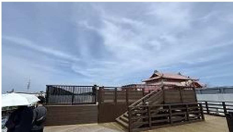
デッキ拡張工事(西側) デッキ供用 (R8 5/1)
