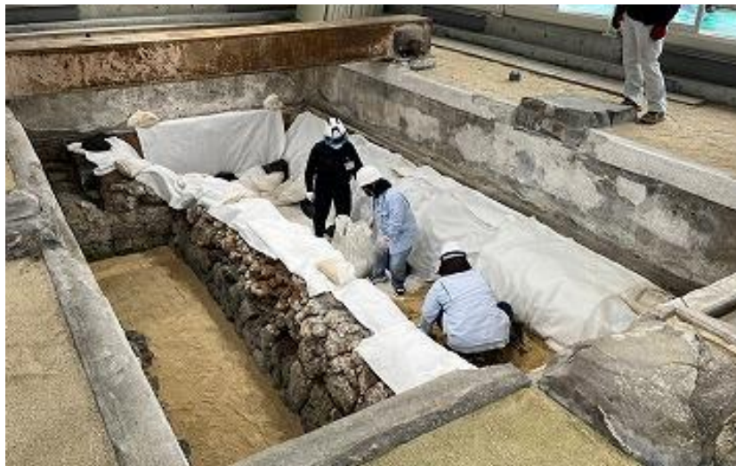
正殿遺構保護 覆砂施工中 (R4 6/3)
