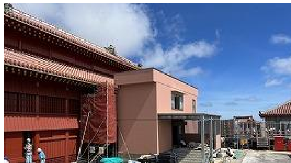
正殿 仮設階段棟 AW枠等、外壁塗装完了 (R8 6/19)
