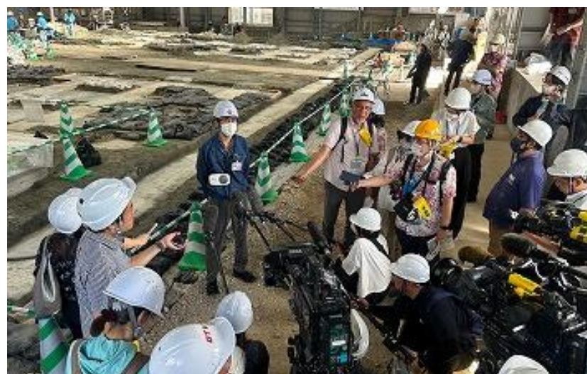
正殿礎石 石材(ニービ)搬入・設置 マスコミ公開状況 (R5 7/10)
