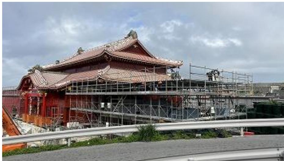
正殿 南之廊下 素屋根組立中 (R7 12/23)
