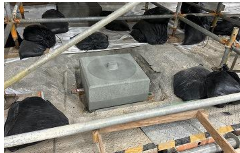
正殿 向拝礎石据付 （R5 10/12）
