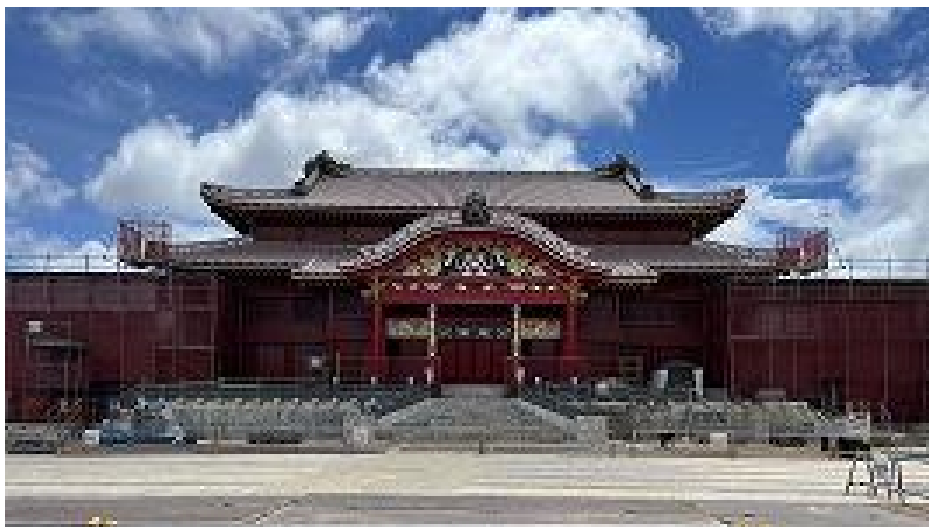
正殿 西側 石階段I高欄施工中 (R8 5/21)
