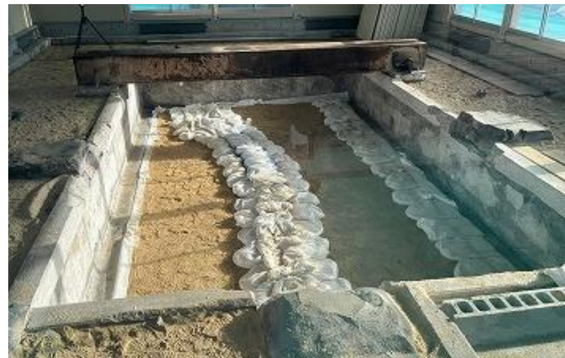
正殿遺構保護 覆砂1次施工完了 (R4 6/22)
