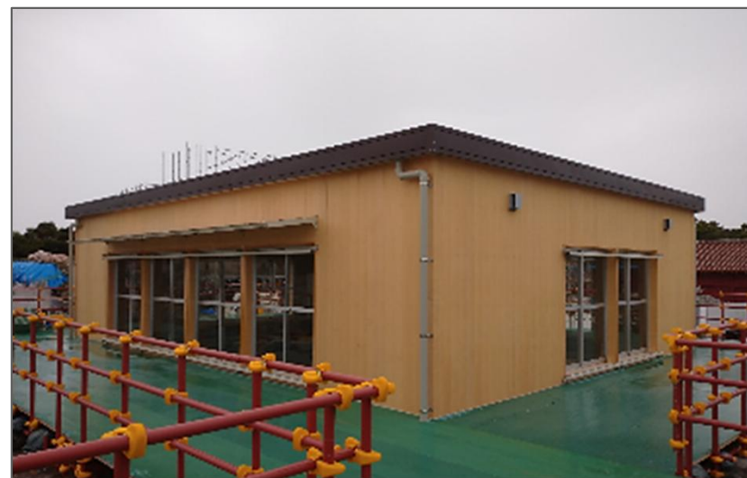
正殿遺構 仮設覆屋 整備完了 (R2 5/21)
