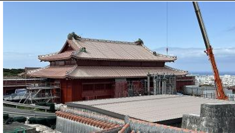
正殿 東側 仮設階段棟 鉄骨建方中 (R8 1/29)
