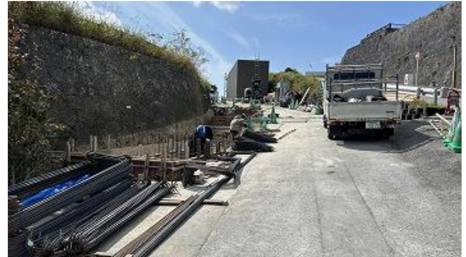
ゲートボックス(東)側より望む 防火水槽基礎型枠中 (R8 2/26)
