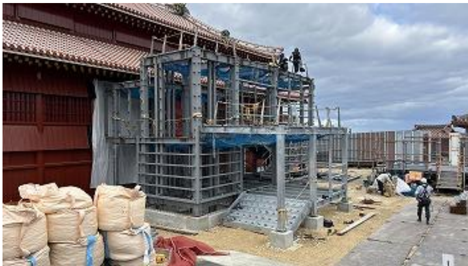
正殿 仮設階段棟 外部足場組立中 (R8 2/9)
