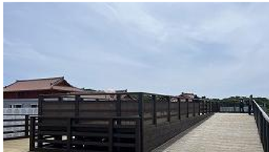
デッキ拡張工事(東側) デッキ供用 (R8 5/1)
