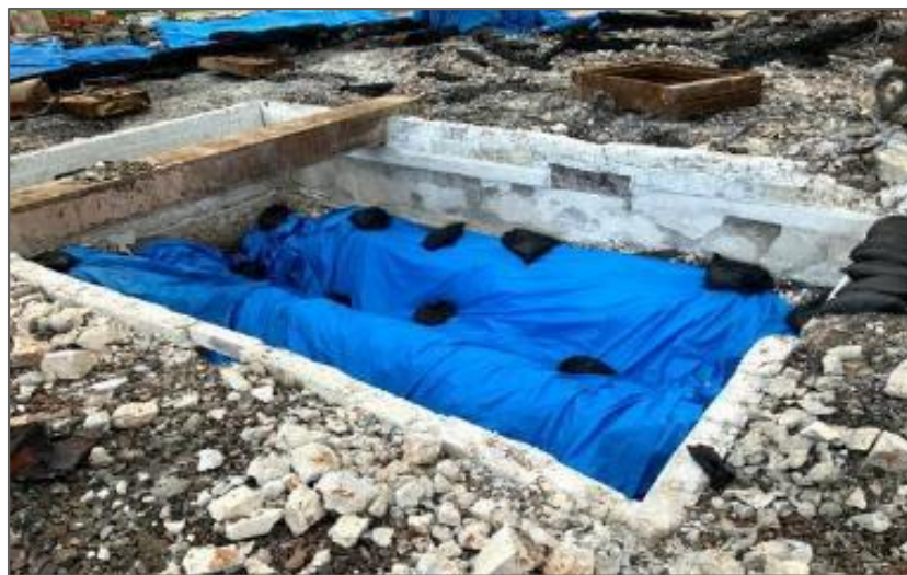
正殿遺構保護 作業着手前 (R2 1/30)
