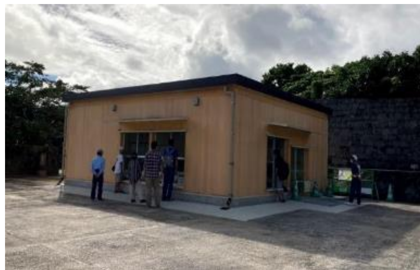
大龍柱補修展示室 作業公開状況(R2 11/6)
