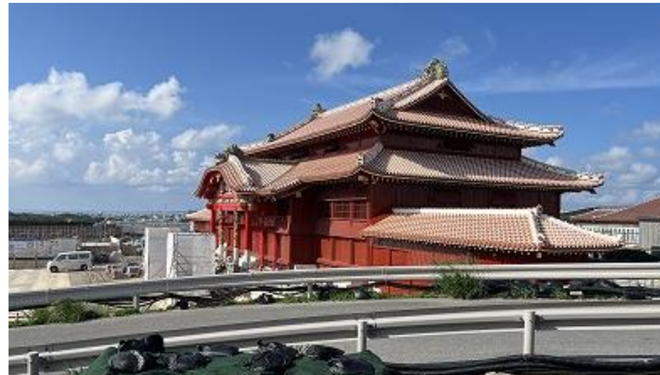
正殿 南之廊下 外部足場解体完了 (R8 7/27)
