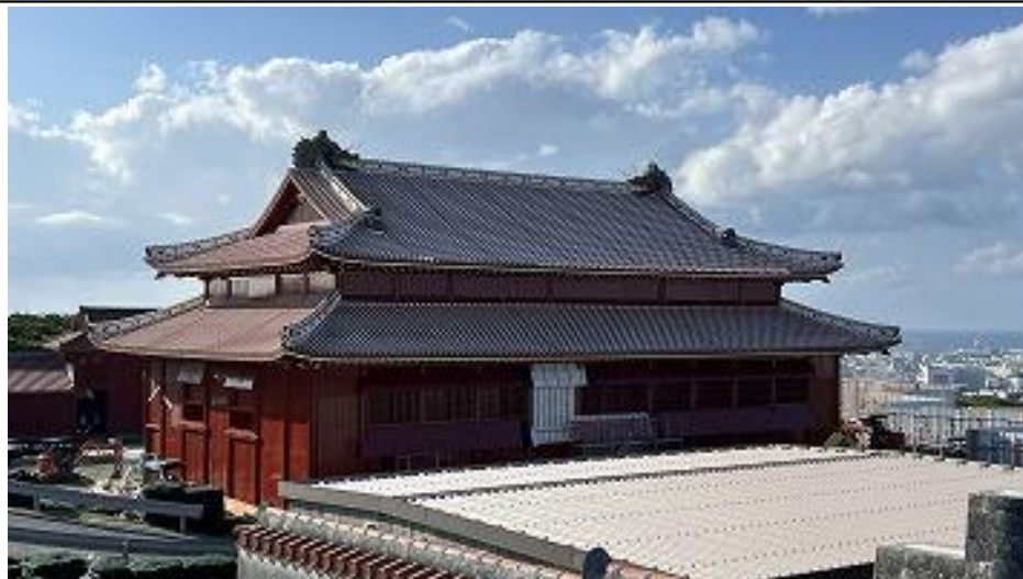
正殿 東側 素屋根基礎等解体中 (R7 10/29)
