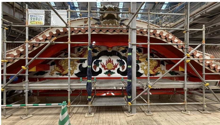
正殿 唐破風妻飾(からはふつまかざり) 設置 2F 西側から東側望む (R7 5/22)
