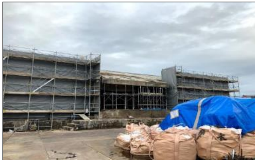
北殿 解体着手前 (R2 3/13)
