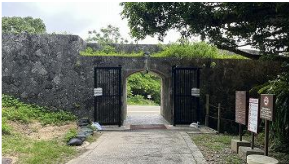
木曳門 アルミ門扉取付完了 (R8 6/23)
