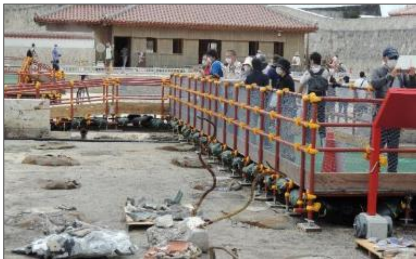
正殿見学デッキ (R2 6/12)
