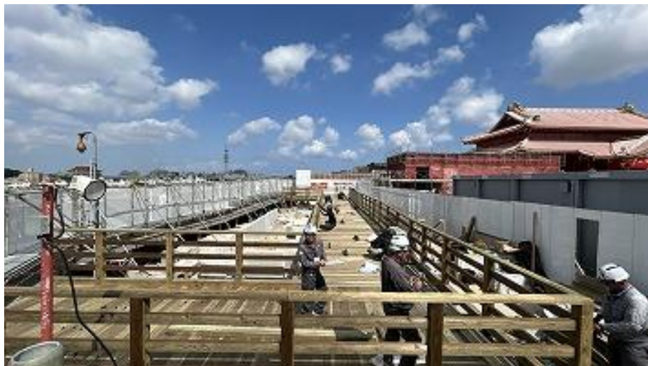
デッキ拡張工事(西側) デッキ設置中 (R8 3/18)
