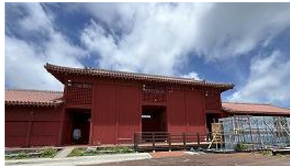
奉神門東側見学デッキバリケード撤去 (R8 5/21)
