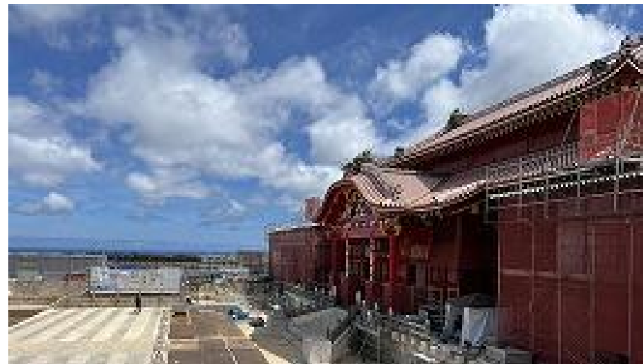
大龍柱 石工事 小龍柱施工完了 (R8 5/21)
