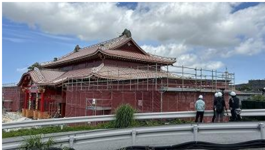
正殿 南之廊下 塗装・瓦工事施工中 (R8 2/26)
