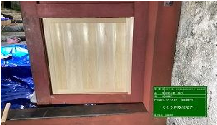
淑順門 仮付け完了 (R8 6/18)
