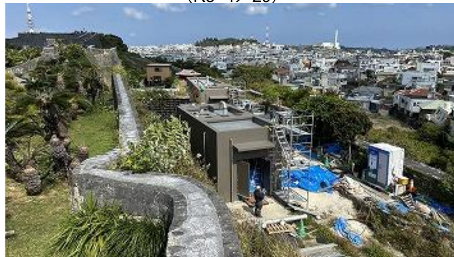
書院鎖之間庭園(南)側より望む 水槽2配管設置中 (R8 3/18)
