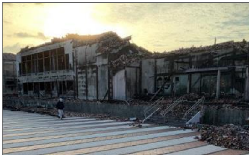
南殿・番所 解体着手前 (R2 1/6)
