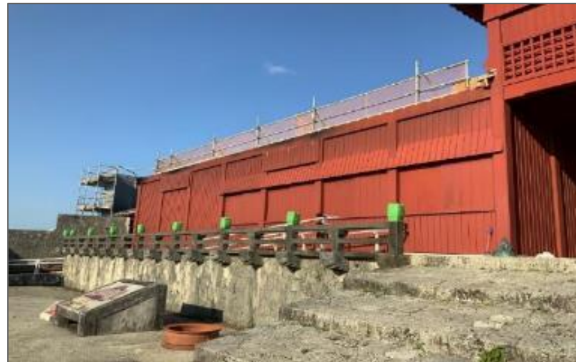
奉神門 応急対策 作業完了 (R2 3/17)
