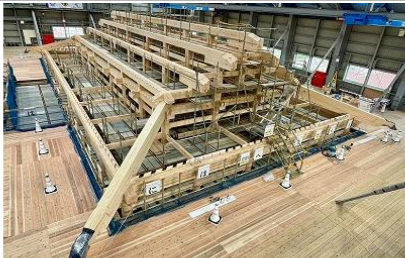
正殿 木工事 上層(棟木建方後) 点検通路 南西側から北東側望む (R5 12/25)
