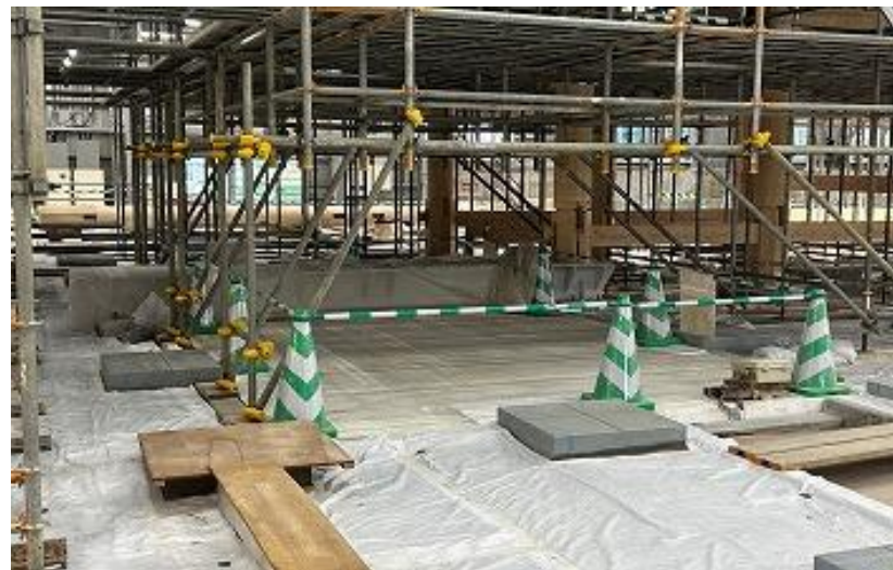
正殿遺構 建方用足場組立完了(R5 9/7)
