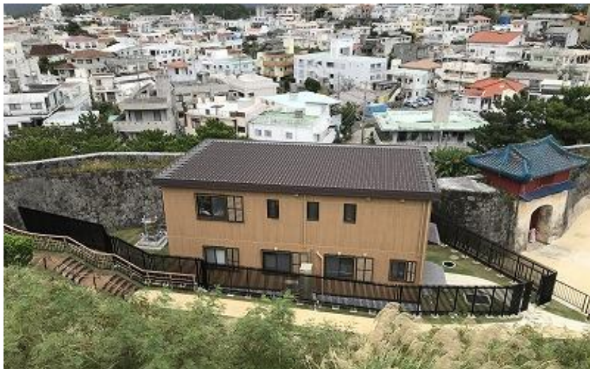
管理施設(北側から望む) 施工完了(R3 11/29)
