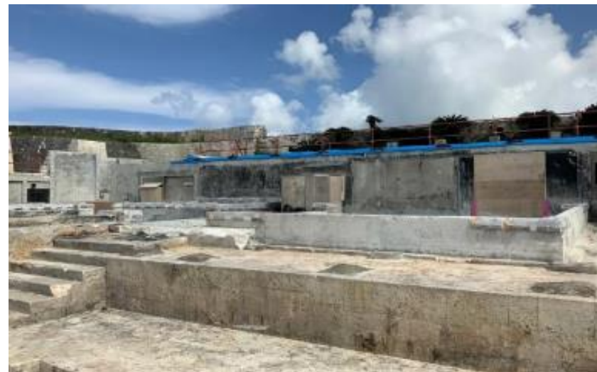
二階御殿 解体完了 (R2 7/31)
