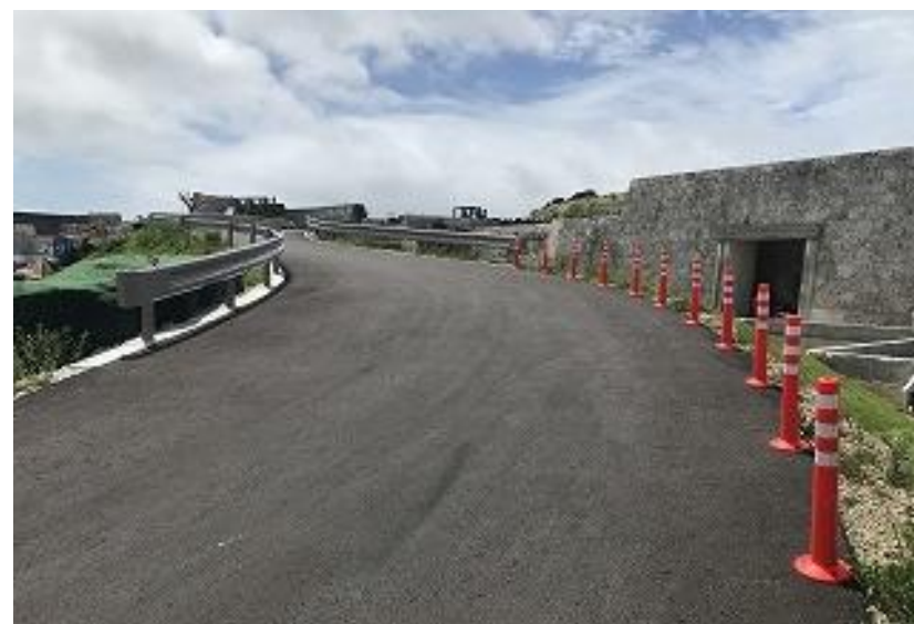
工事用仮設道路(南殿・番所) 施工完了(R3 6/1)
