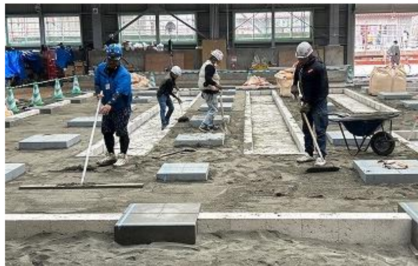
正殿床下 砂埋戻し中 (R5 8/9)
