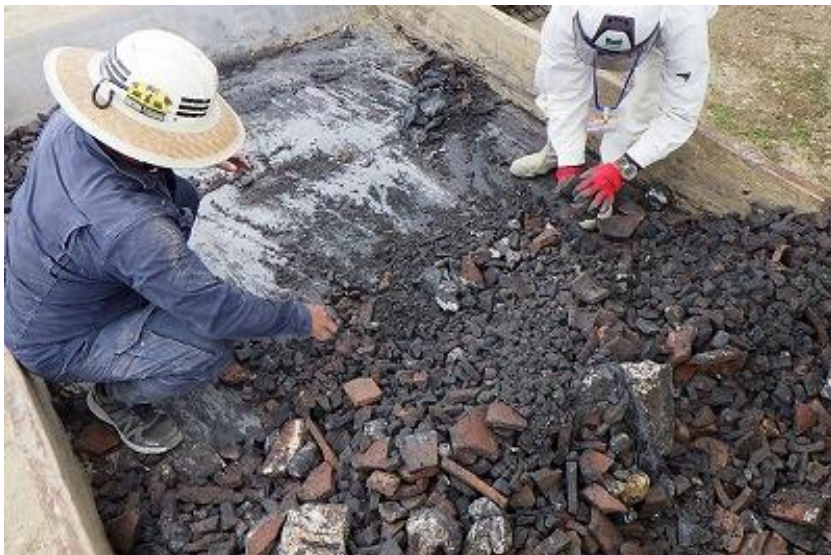
破損瓦・燃え殻分別中(R5 4/27)
