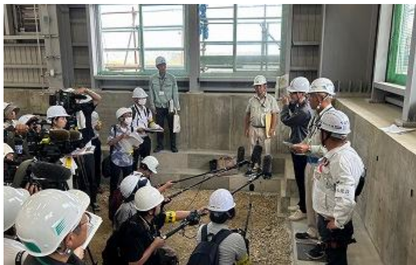
正殿木軸建方 下層柱建方 マスコミ公開状況 (R5 9/4)
