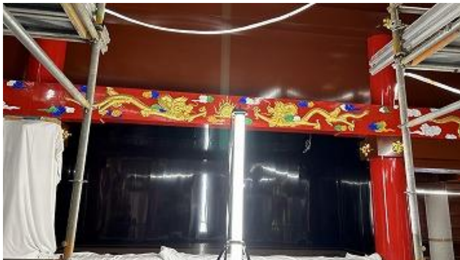
正殿内部 塗装工事 御差床2F 内法額木上塗り中 (R8 2/16)
