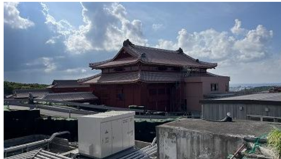
正殿 東側 仮設階段棟 外部足場解体完了 (R8 7/27)
