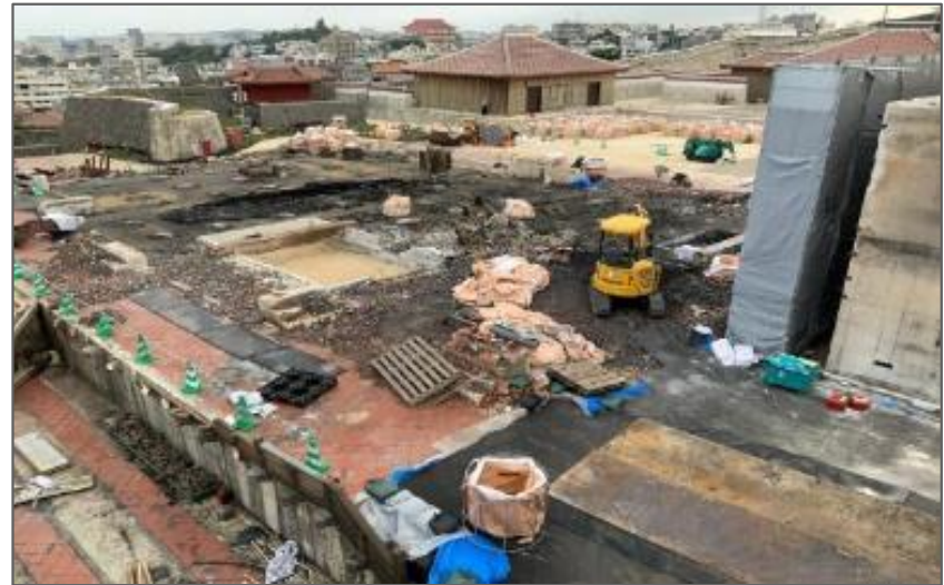
正殿 破損瓦等撤去 作業中 (R2 3/9)
