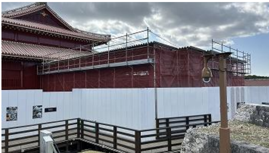
正殿 西之廊下 木工事施工中 (R8 1/23)
