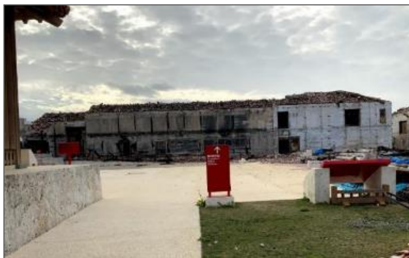
黄金御殿・寄満 解体着手前 (R1 12/28)
