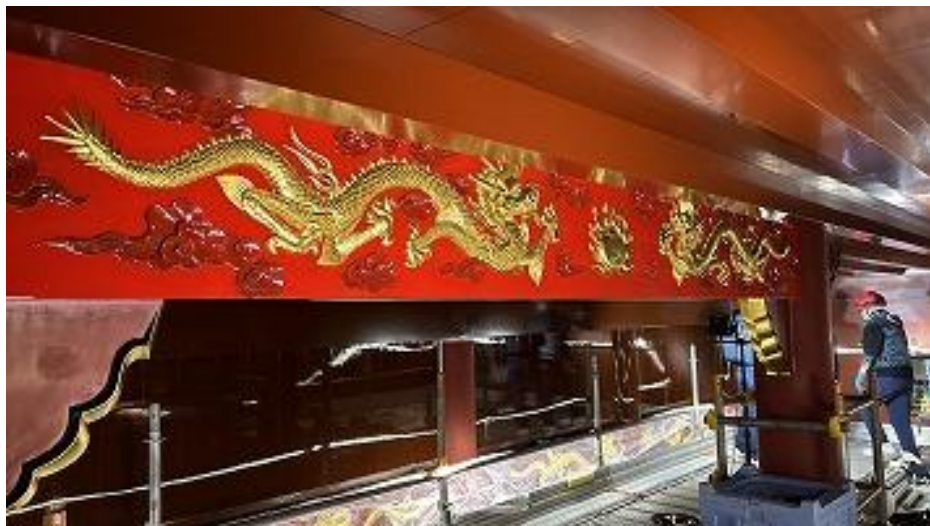
正殿内部 塗装工事 御差床2F 天井額木上塗り中 (R7 10/16)
