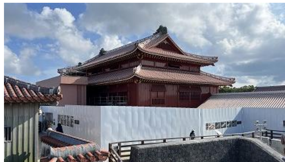
正殿 西之廊下 外部足場解体完了 (R8 7/27)
