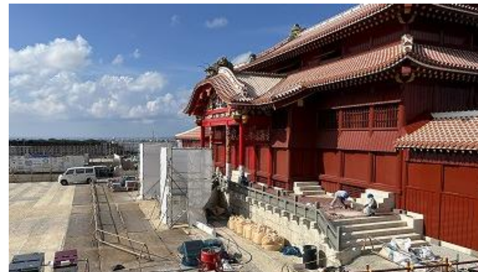
大龍柱 石工事 強化剤塗布養生中 (R8 7/28)
