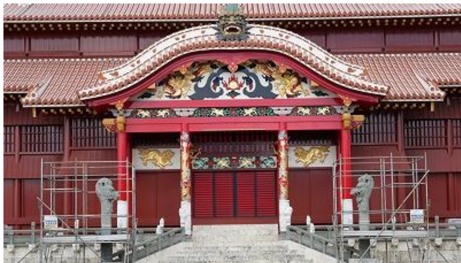
大龍柱 石工事 接合部仕上げ彫り中 (R8 7/23)
