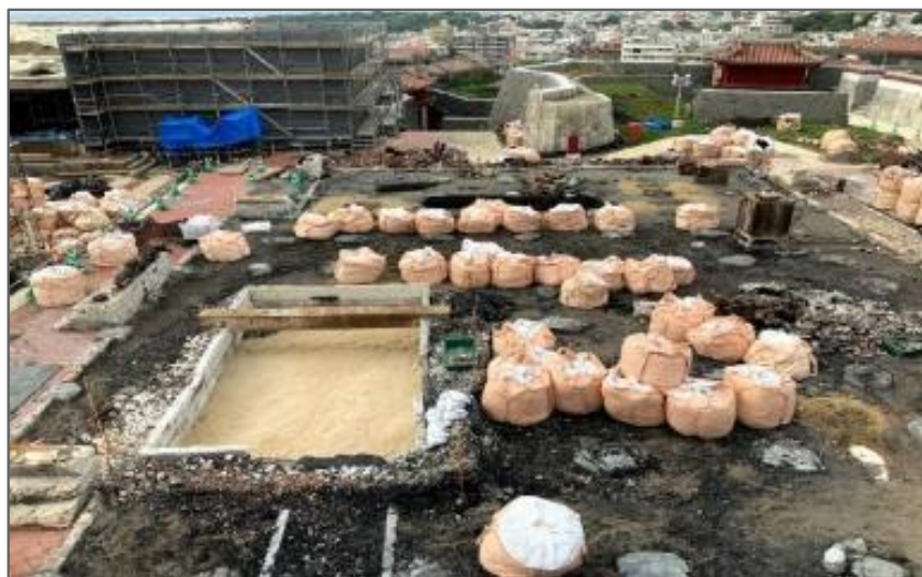
正殿 破損瓦等撤去 作業中 (R2 3/14)
