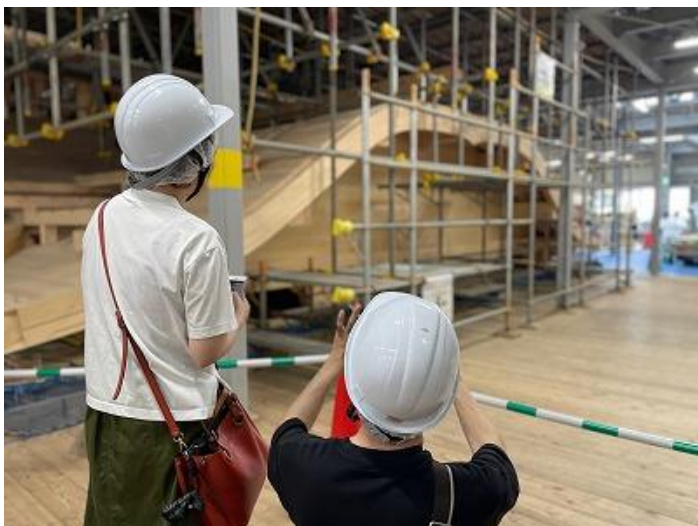
素屋根内(正殿)見学中
