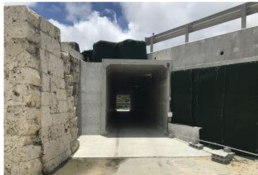
工事用仮設道路(ワイトゥイ) 照明設備施工完了(R3 7/28)
