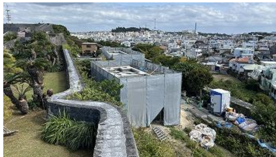
書院鎖之間庭園(南)側より望む 水槽2内部防水塗装中 (R8 1/29)
