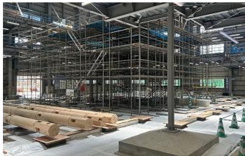
正殿仮設 建方用足場組立施工 1F (R5 8/30)
