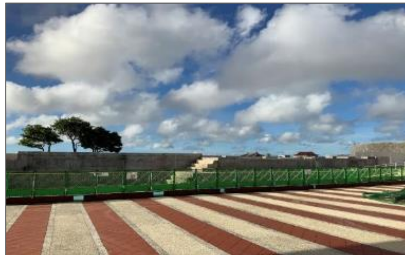
北殿 解体完了 (R2 5/7)
