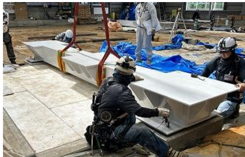
正殿遺構 ステンレス梁設置 (R5 6/28)
