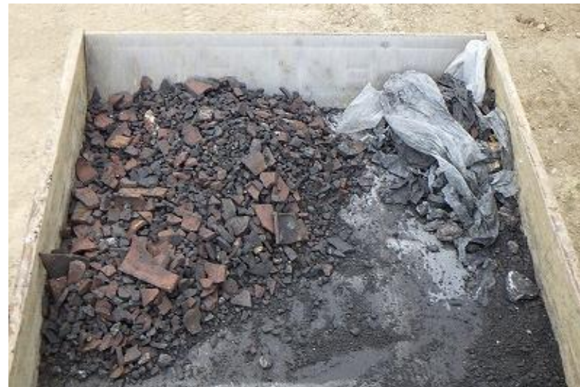
破損瓦・燃え殻分別中(R5 4/27)
