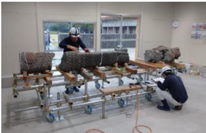
大龍柱 補修作業状況(R2 11/5)
