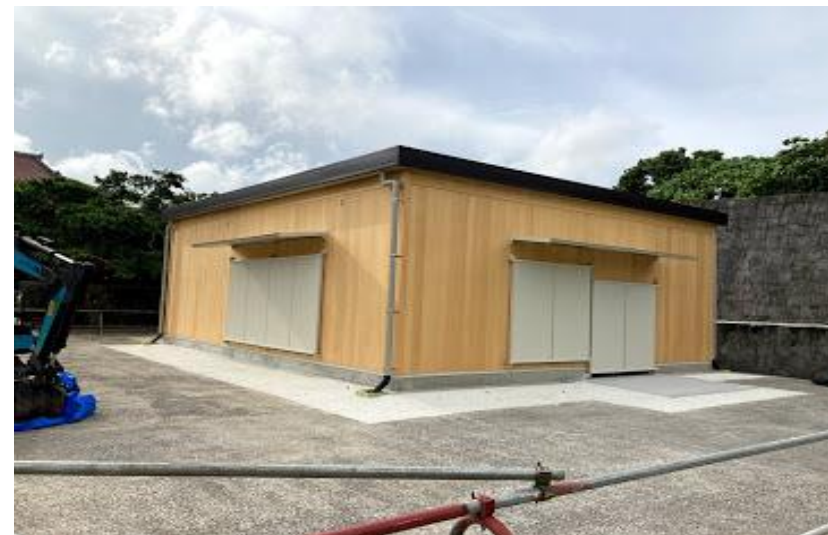
大龍柱補修展示室 整備完了(R2 8/31)
