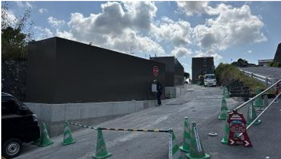
ゲートボックス(東)側より望む 防火水槽設置後 (R8 3/18)
