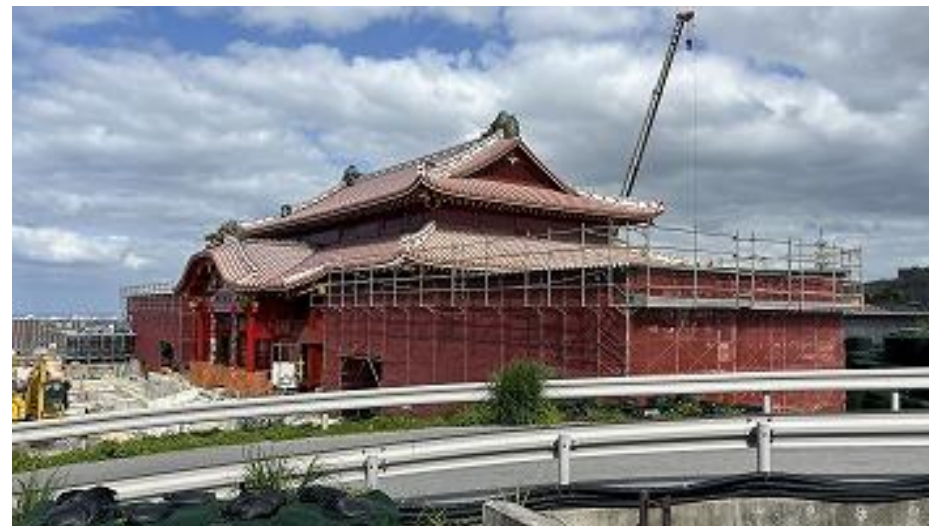
正殿 南之廊下 木工事施工中 (R8 1/29)
