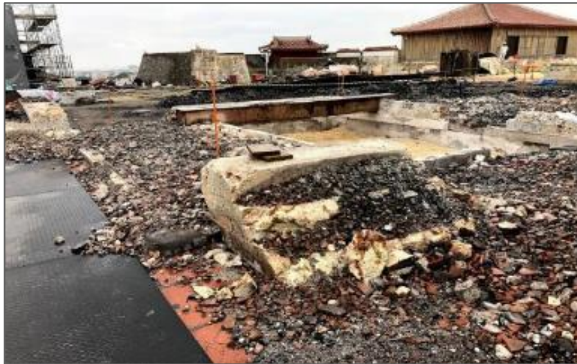
正殿 破損瓦等撤去 作業着手前 (R2 3/5)
