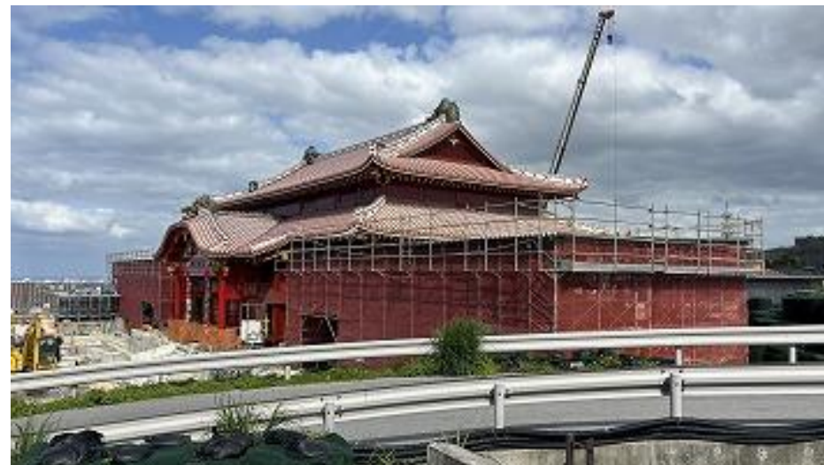
正殿 南之廊下 木工事施工中 (R8 1/29)
