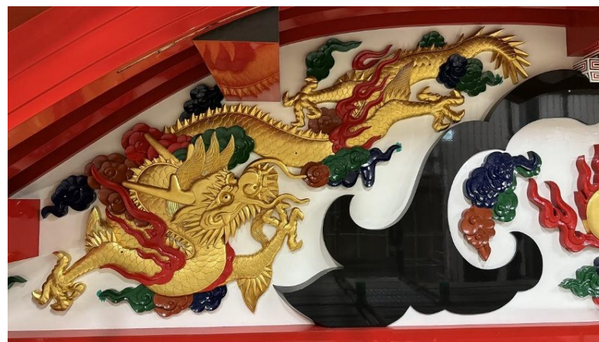
正殿唐破風妻飾(からはふつまかざり)設置完了 (R7 5/22)
