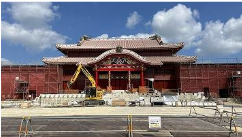
正殿 西側 持送り石、石階段施工中 (R8 3/18)
