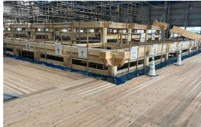
正殿 木工事(上層軸組建方) 3F 南西側から北東側望む (R5 12/14)
