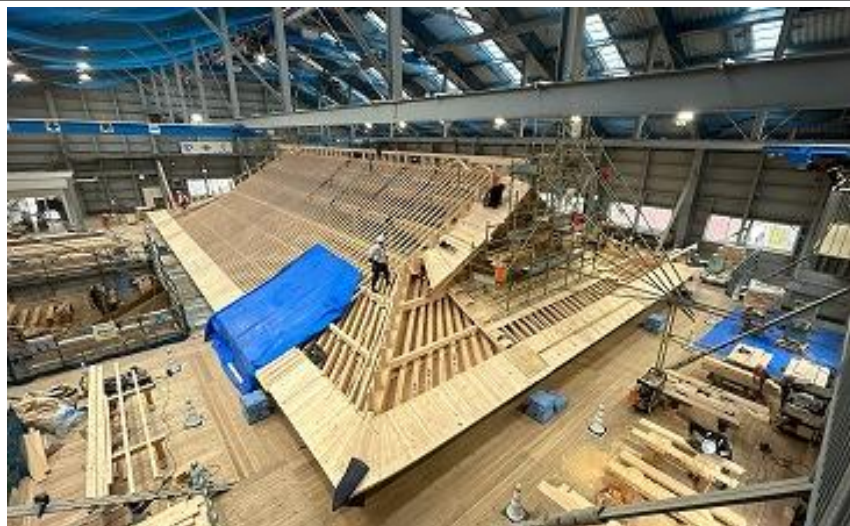
正殿 木工事 上層屋根(妻廻り、切裏甲建込中) 点検通路 南西側から北東側望む (R6 4/25)
