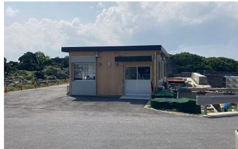
工事警備室(東)側 施工完了 (R4 9/27)
