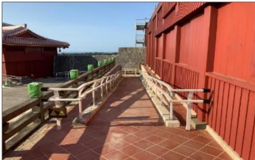
奉神門 応急対策 作業完了 (R2 3/17)
