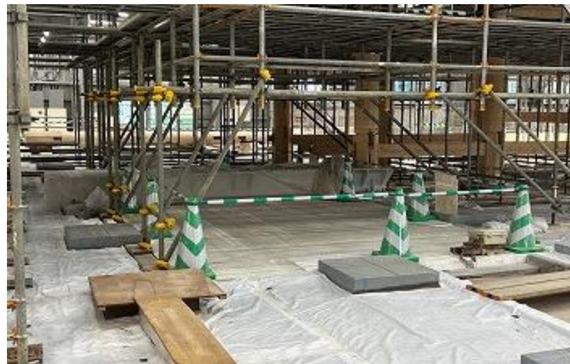
正殿遺構 建方用足場組立完了(R5 9/7)
