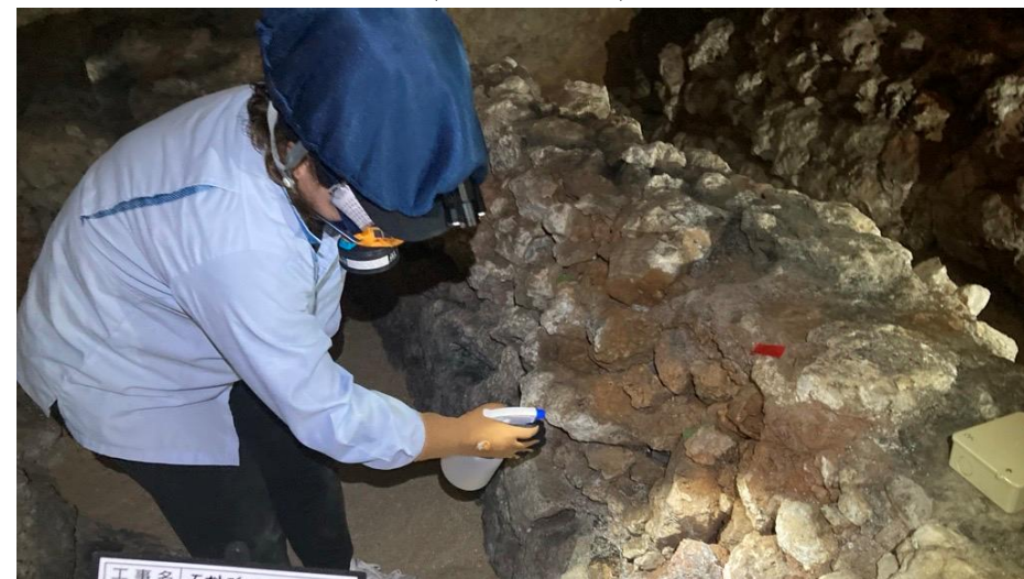
正殿遺構 石材強化の為の薬剤散布状況 (R7 6/21)
