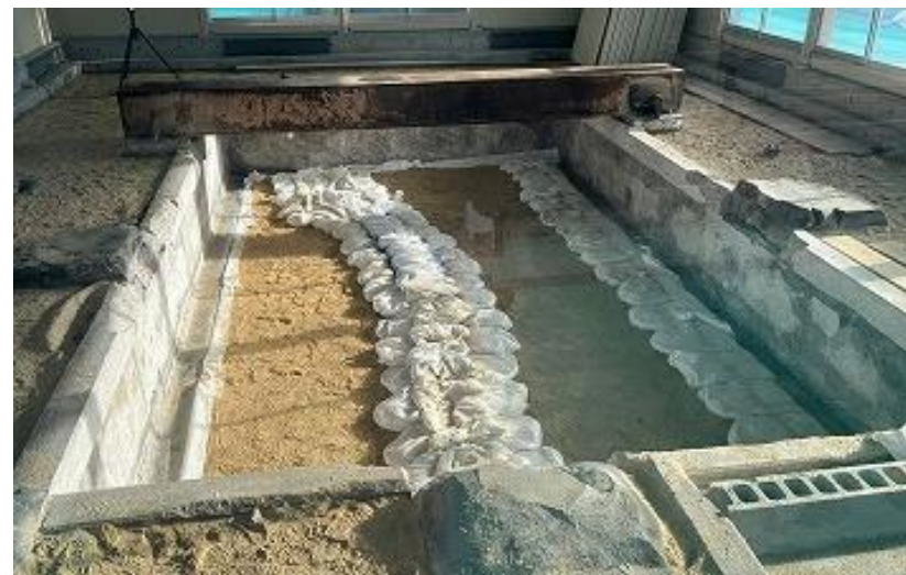
正殿遺構保護 覆砂1次施工完了 (R4 6/22)
