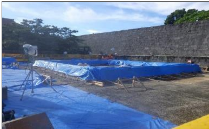
大龍柱補修展示室 施工状況(R2 7/27)
