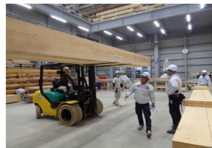
搬入時立会検査(目視検査)
