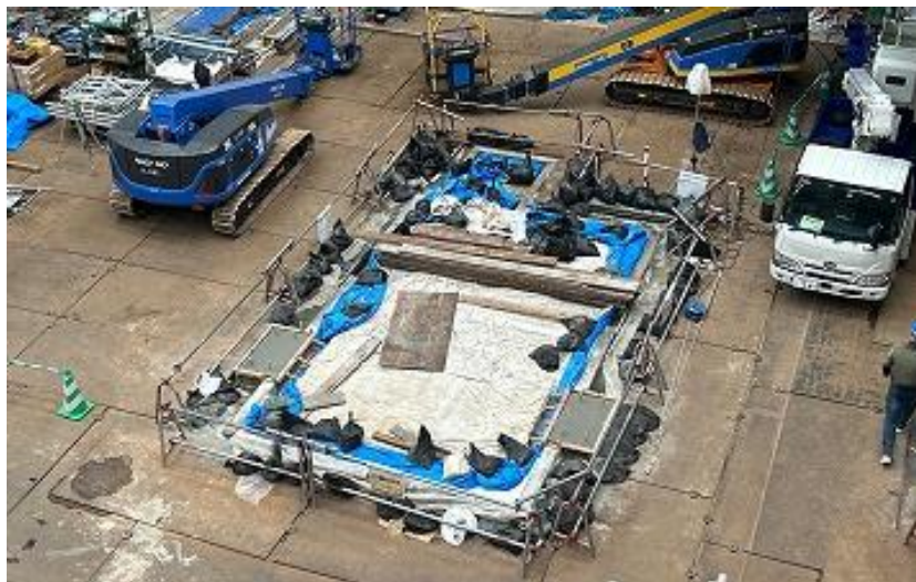
正殿遺構 ステンレス梁基礎CO打設 (R5 6/22)
