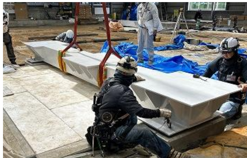
正殿遺構 ステンレス梁設置 (R5 6/28)
