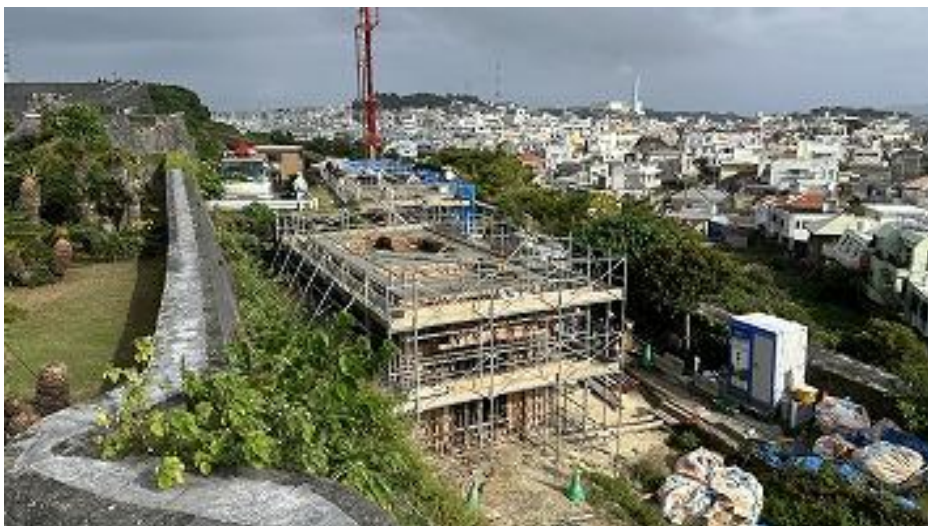
書院鎖之間庭園(南)側より望む 水槽2コンクリート打設中 (R7 12/23)
