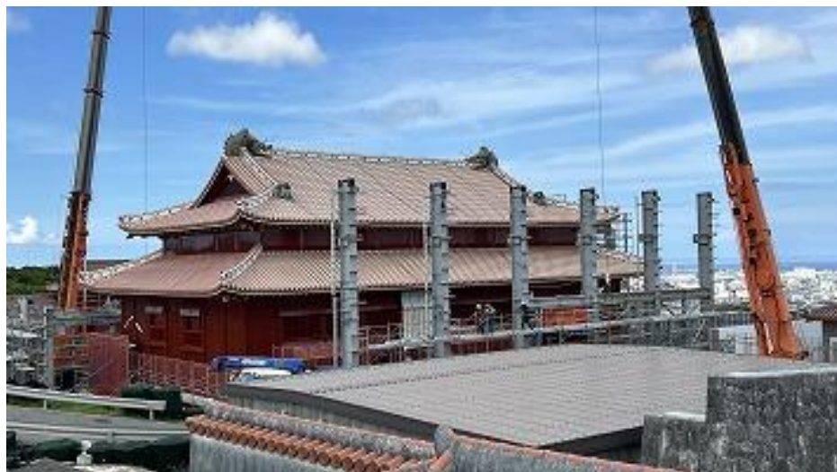
正殿 東側 素屋根鉄骨解体中 (R7 9/29)
