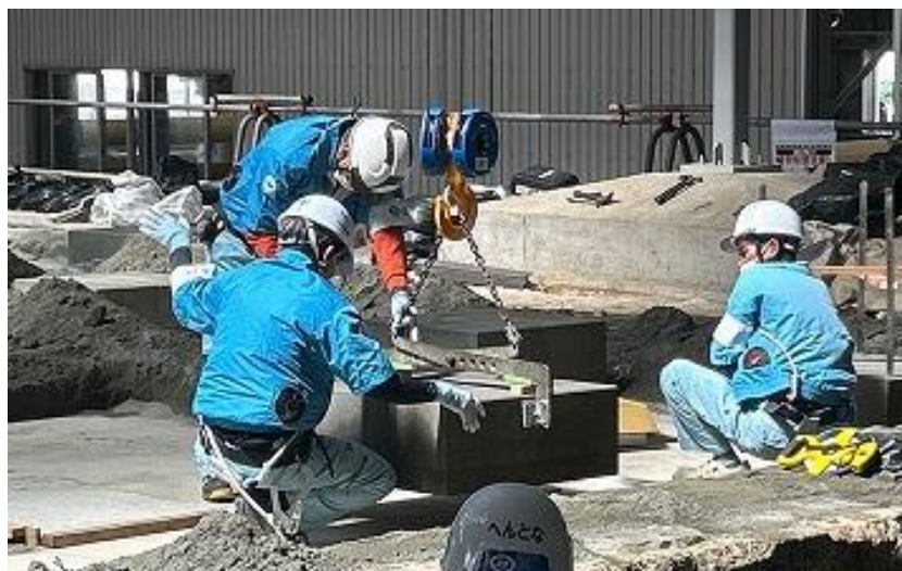
正殿礎石 石材(ニービ)設置中 (R5 7/10)
