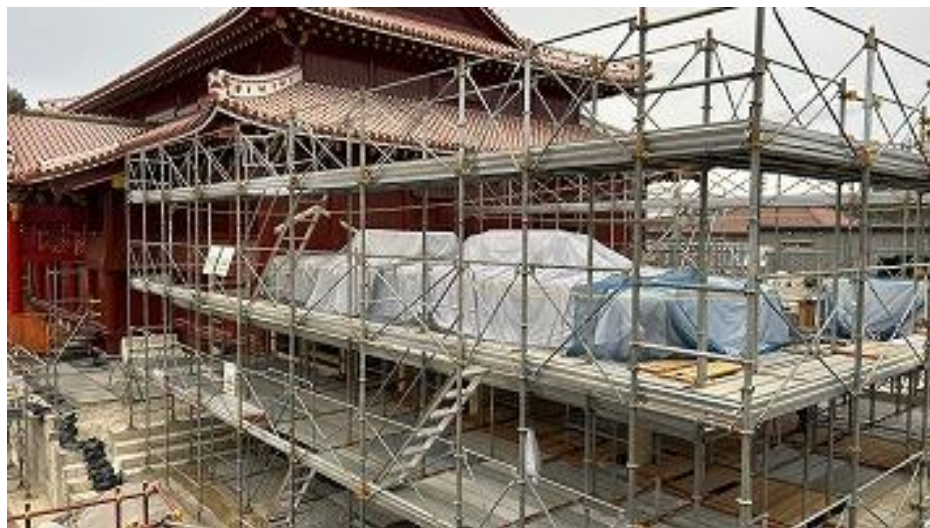
正殿 南之廊下 軸組建方中 (R7 12/19)
