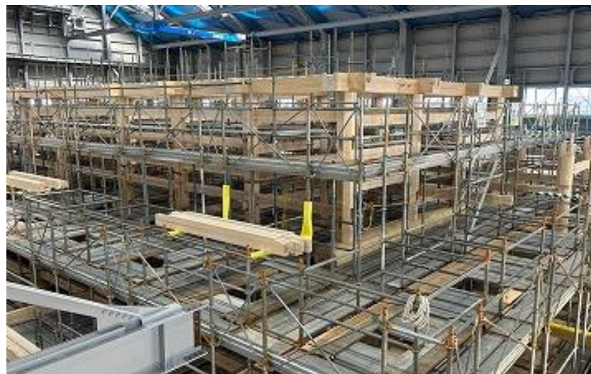
正殿 木工事(上層軸組建方) 3F 南西側から北東側望む (R5 11/29)
