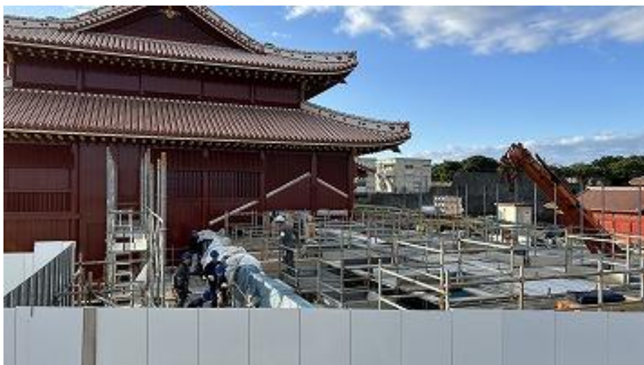
正殿 西之廊下 軸組建方中 (R7 12/5)
