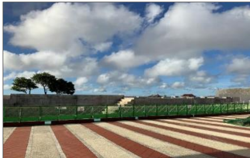
北殿 解体完了 (R2 5/7)
