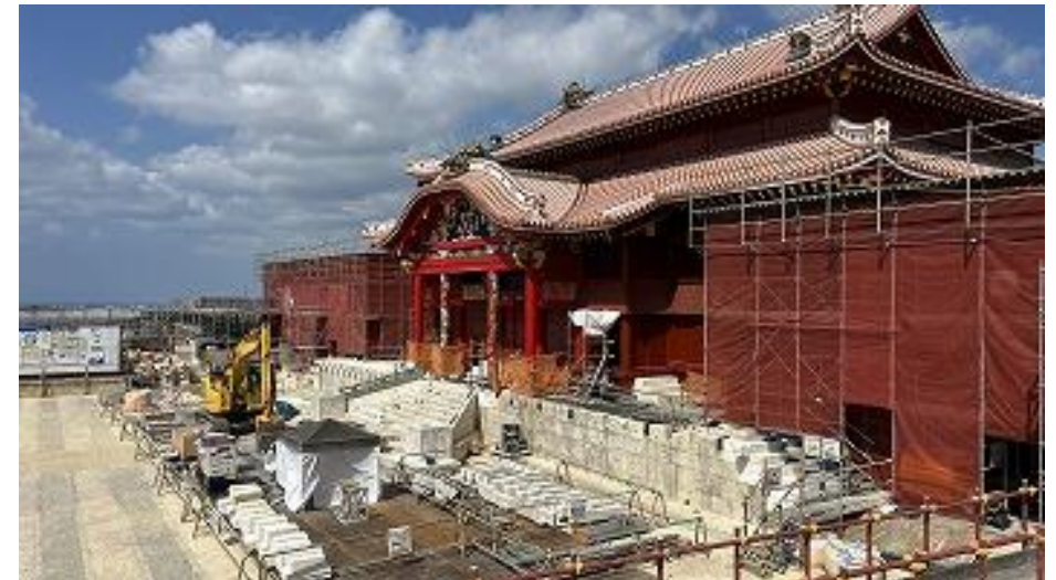
大龍柱 石工事 持ち送り石設置中 (R8 3/18)
