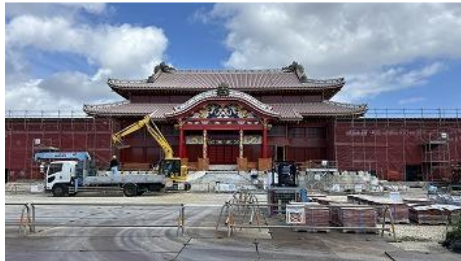
正殿 西側 持送り石、石階段施工中 (R8 2/26)
