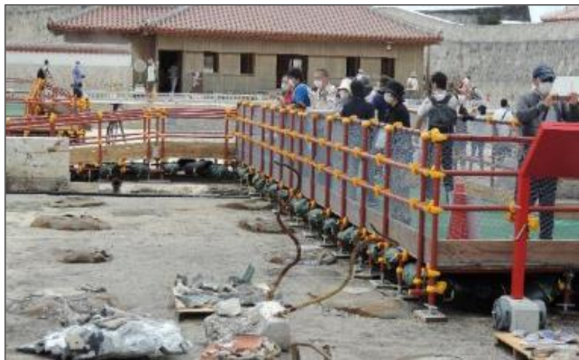
正殿見学デッキ (R2 6/12)
