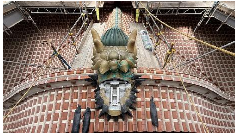
正殿 唐玻豊(からはふう)龍頭棟飾り設置中 3F 上側から望む (R7 6/25)
