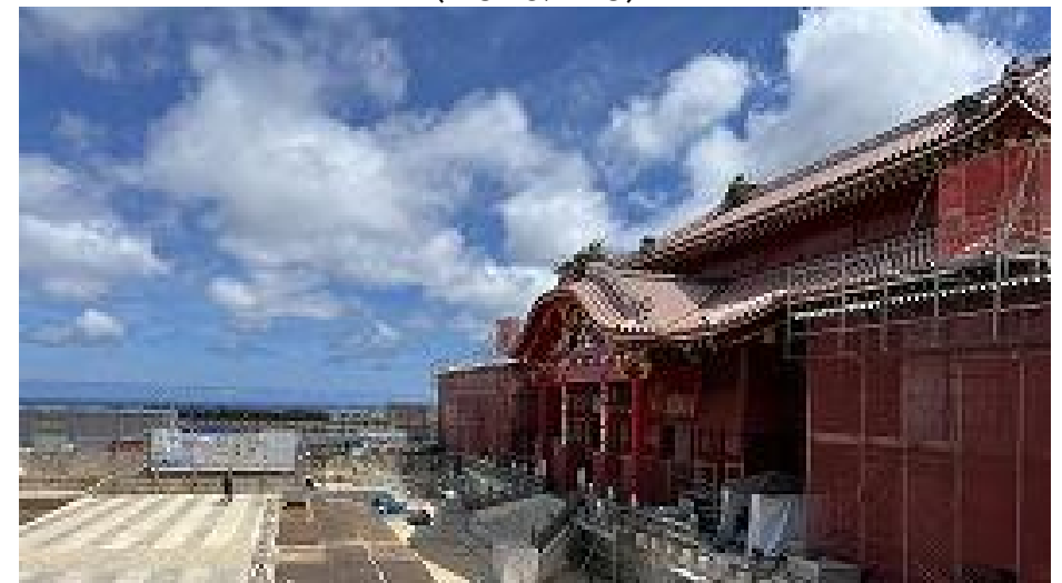
大龍柱 石工事 小龍柱施工完了 (R8 5/21)
