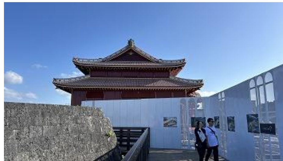
素屋根(北側) 木製見学デッキ供用中 (R7 10/29)
