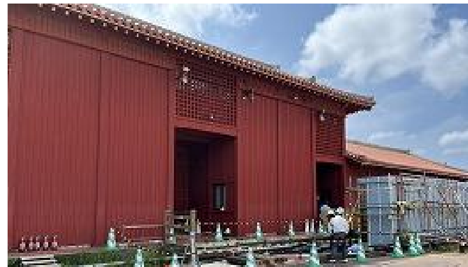
奉神門東側見学デッキ施工中 (R8 4/22)
