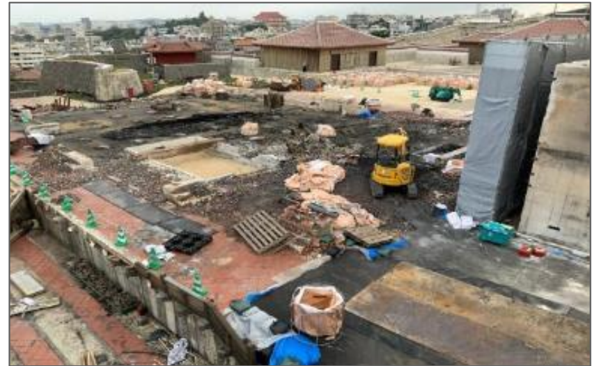
正殿 破損瓦等撤去 作業中 (R2 3/9)
