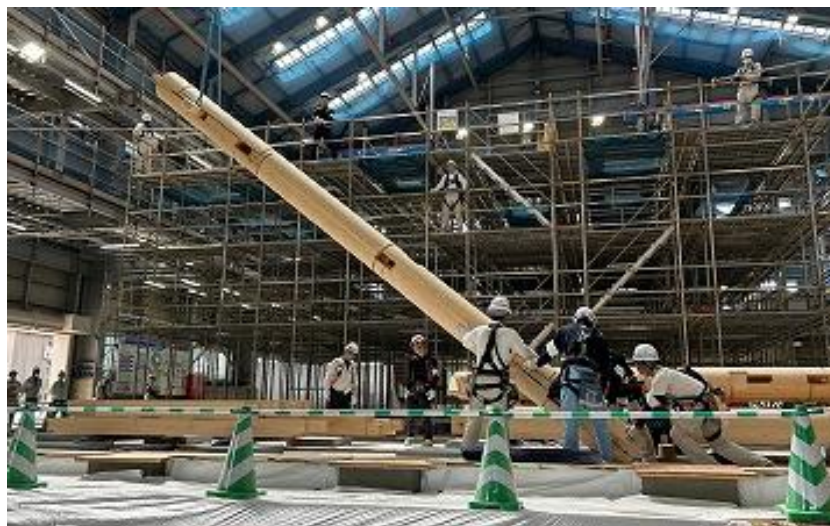
正殿木軸建方 下層柱建方1本目吊上げ中 1F (R5 9/4)
