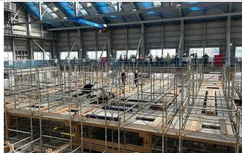
正殿 木工事(下層軸組建方) 3F 西側から東側望む (R5 10/27)
