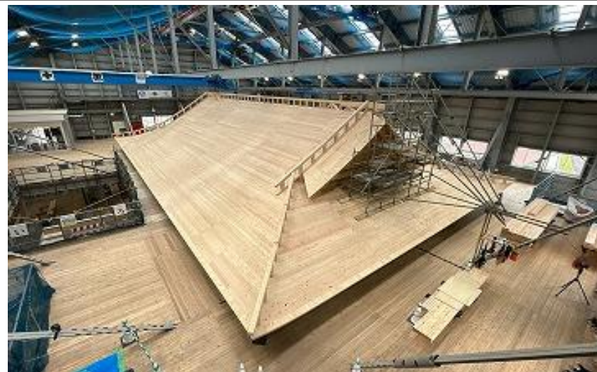
正殿 木工事 上層屋根(野地板完了) 点検通路 南西側から北東側望む (R6 5/30)
