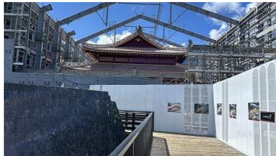
素屋根(北側) 木製見学デッキ供用中 (R7 9/16)
