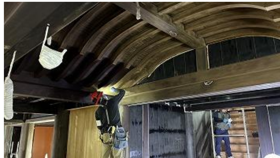
正殿内部 塗装工事 御差床1F 漆塗り中 (R7 11/17)
