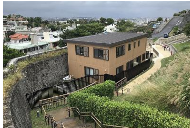
管理施設(東側から望む) 施工完了(R3 11/29)
