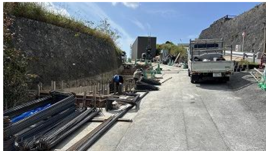
ゲートボックス(東)側より望む 防火水槽基礎型枠中 (R8 2/26)
