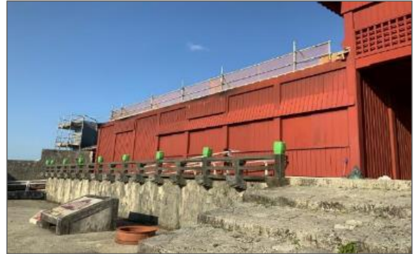
奉神門 応急対策 作業完了 (R2 3/17)
