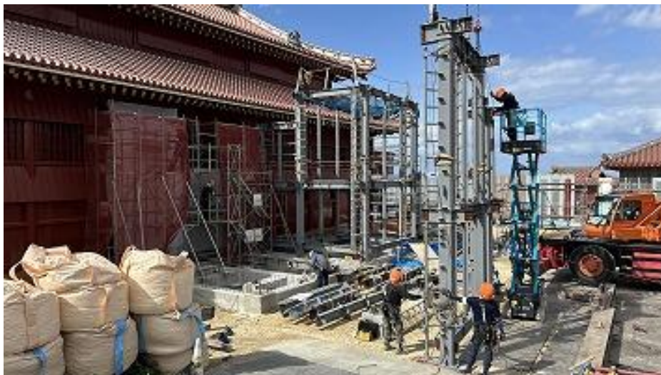
正殿 仮設階段棟 鉄骨建方中 (R8 1/29)
