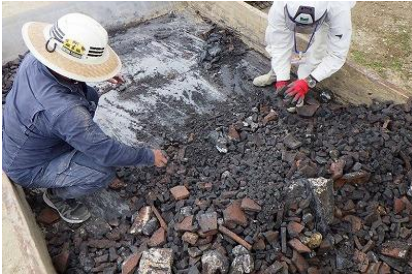
破損瓦・燃え殻分別中(R5 4/27)
