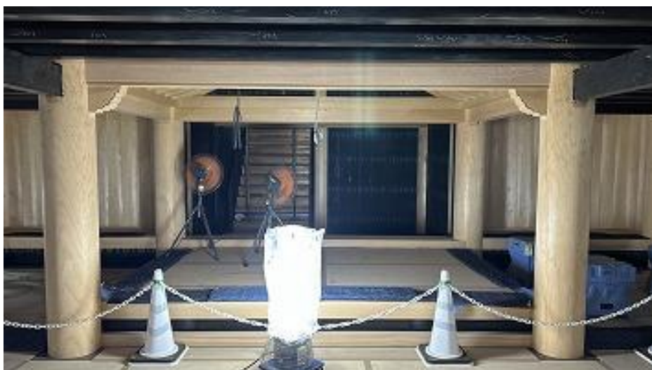
正殿 塗装工事 御差床1F 塗装前 (R7 10/16)
