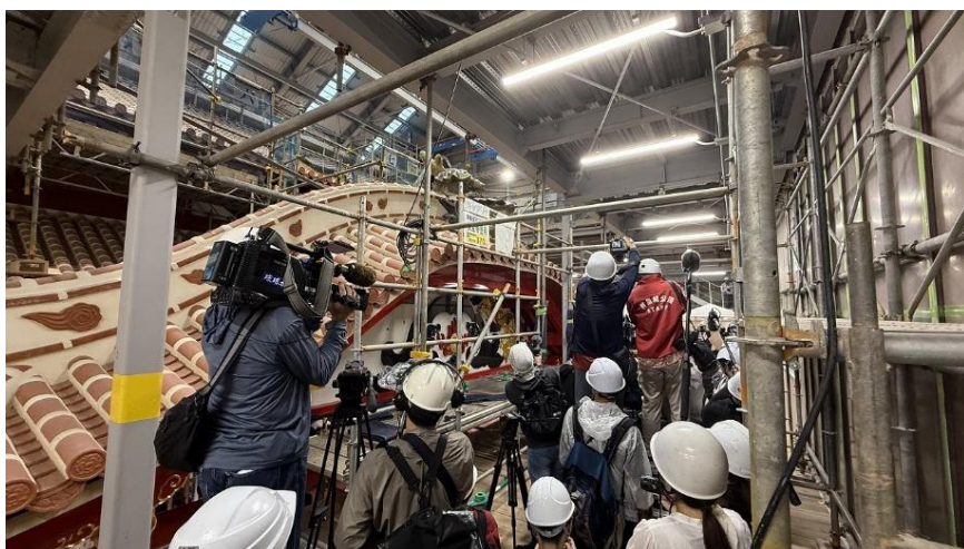
正殿唐破風妻飾(からはふつまかざり)設置状況公開 (R7 5/22)
