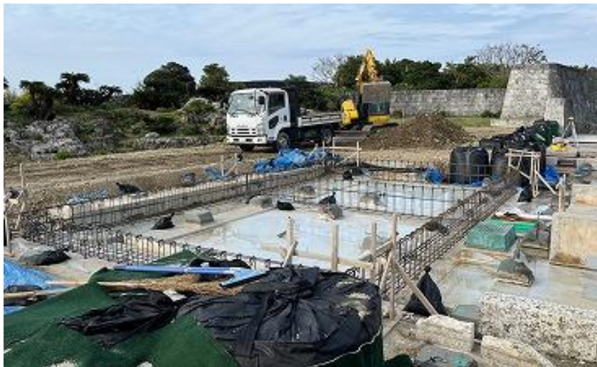
工事警備室(東)側 基礎鉄筋組立完了 (R4 2/28)
