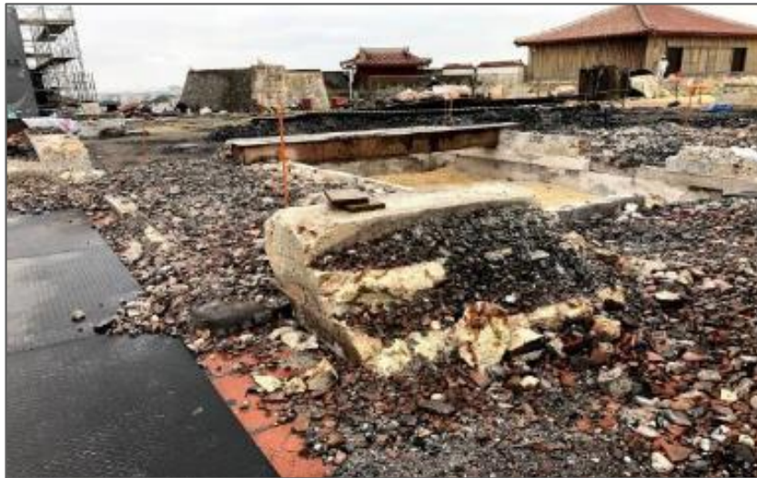
正殿 破損瓦等撤去 作業着手前 (R2 3/5)
