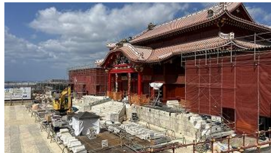
大龍柱 石工事 持ち送り石設置中 (R8 3/18)
