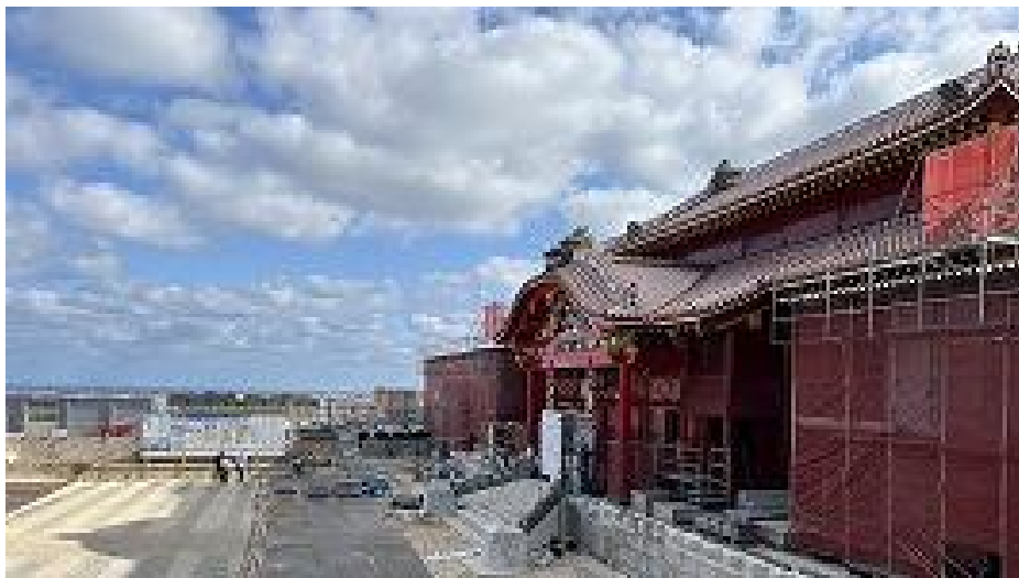
大龍柱 石工事 小龍柱仕口加工中 (R8 4/20)
