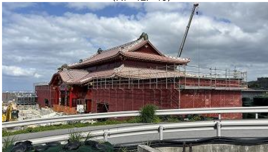
正殿 南之廊下 木工事施工中 (R8 1/29)
