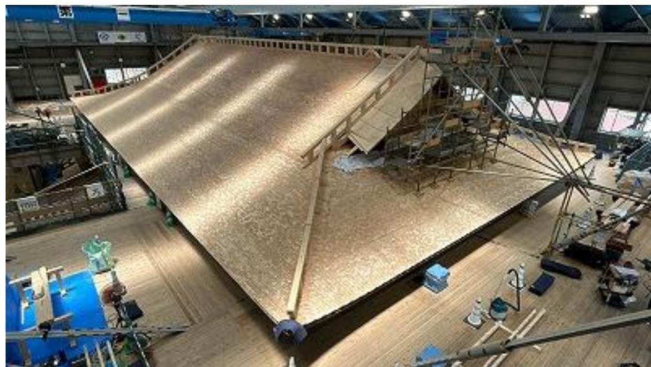
正殿 屋根工事 上層屋根(土居葺き完了、瓦座取付中) 点検通路 南西側から北東側望む (R6 6/26)
