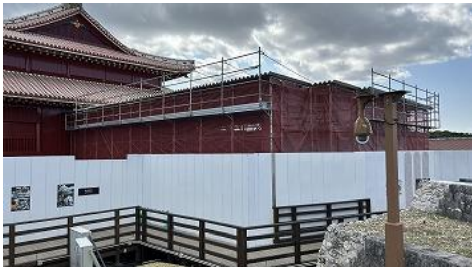
正殿 西之廊下 木工事施工中 (R8 1/23)
