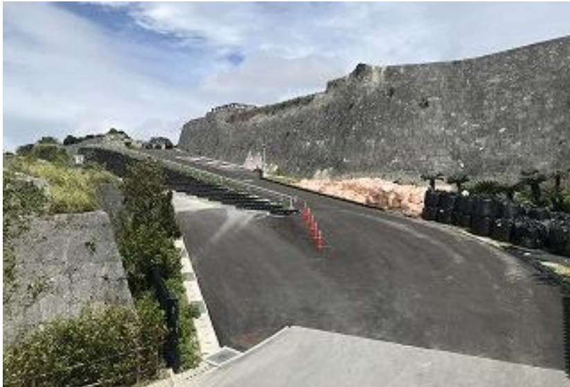
工事用仮設道路(ガードマンBOX前) 施工完了(R3 6/1)
