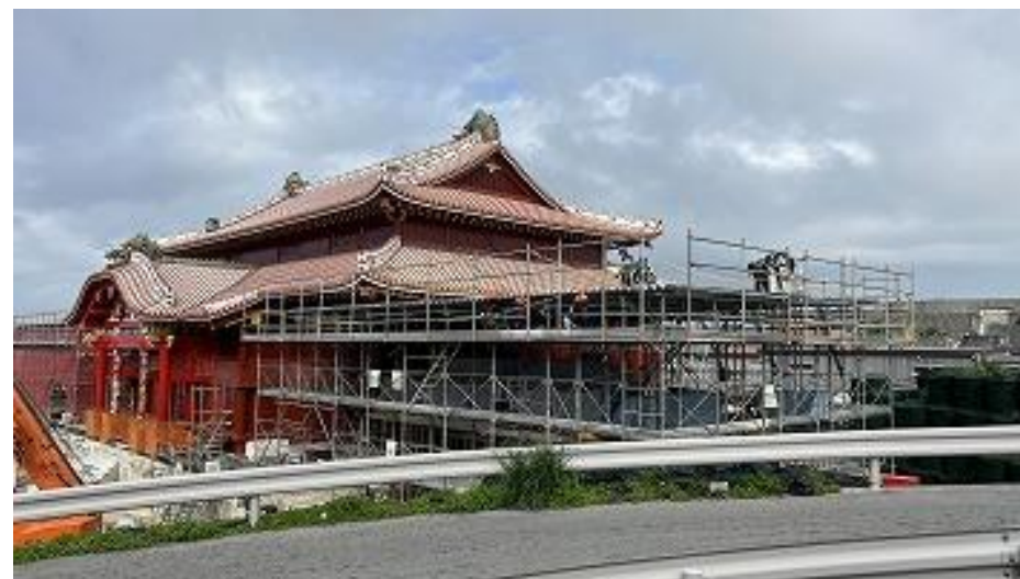
正殿 南之廊下 素屋根組立中 (R7 12/23)
