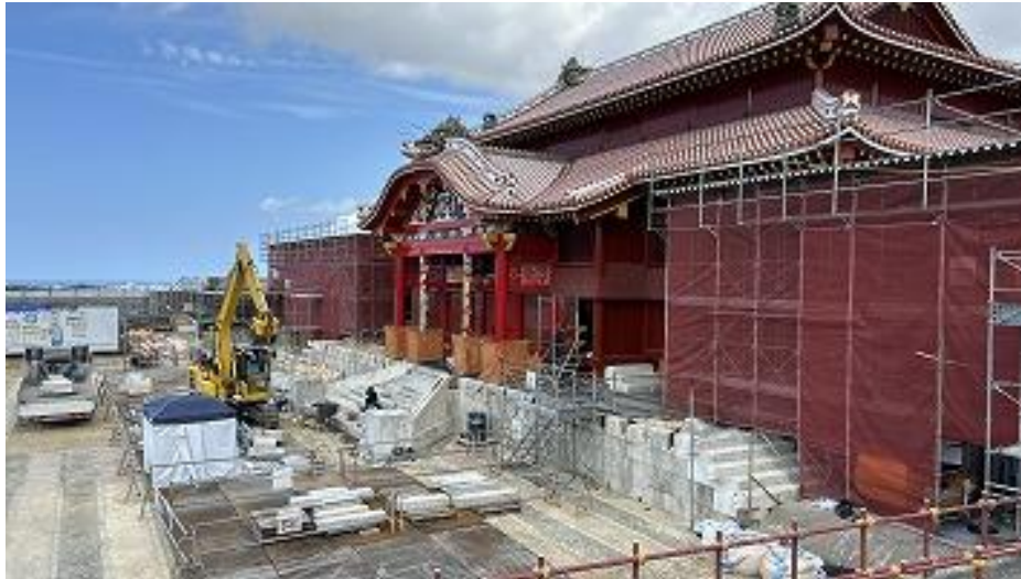
大龍柱 石工事 石階段設置中 (R8 2/26)
