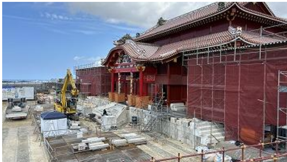
大龍柱 石工事 石階段設置中 (R8 2/26)
