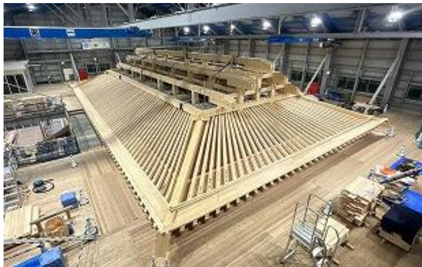
正殿 木工事 上層(飛燕垂木等建込中) 点検通路 南東側から北西側望む (R6 2/28)
