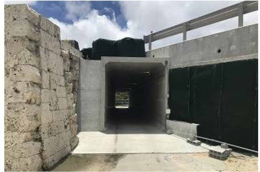
工事用仮設道路(ワイトウイ) 照明設備施工完了(R3 7/28)
