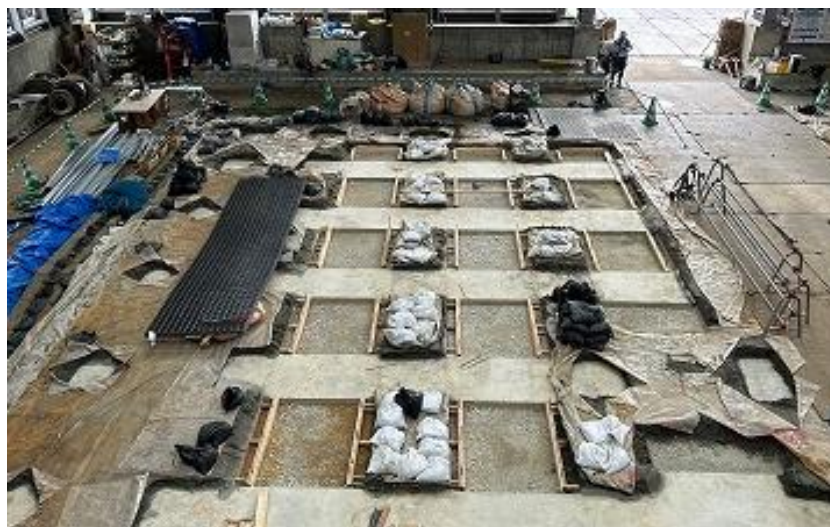
正殿礎石 碎石敷き・型枠施工中 (R5 7/4)
