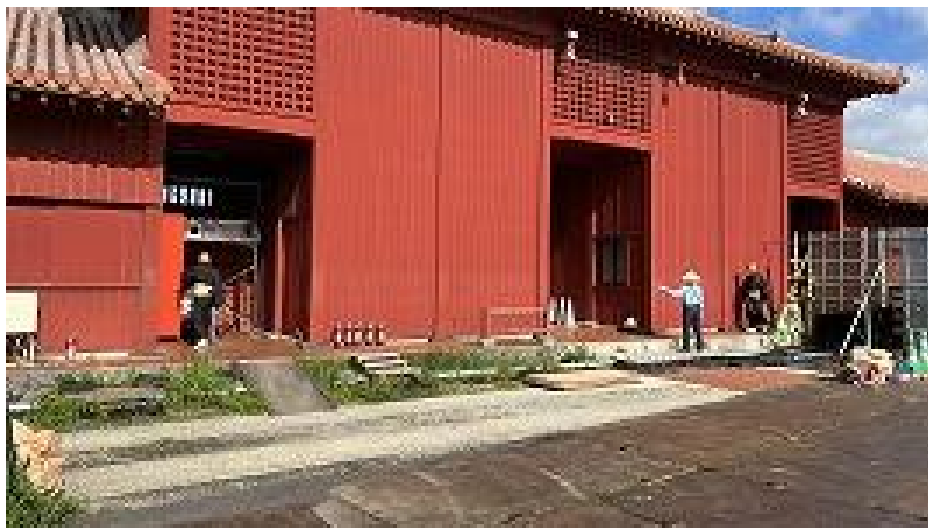
奉神門東側見学デッキ施工前 (R8 4/20)
