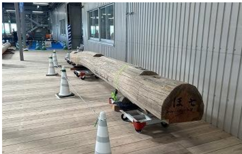
正殿素屋根2F回廊 オキナワウラジログシ 2F 防腐防蟻中 (R5 10/19)
