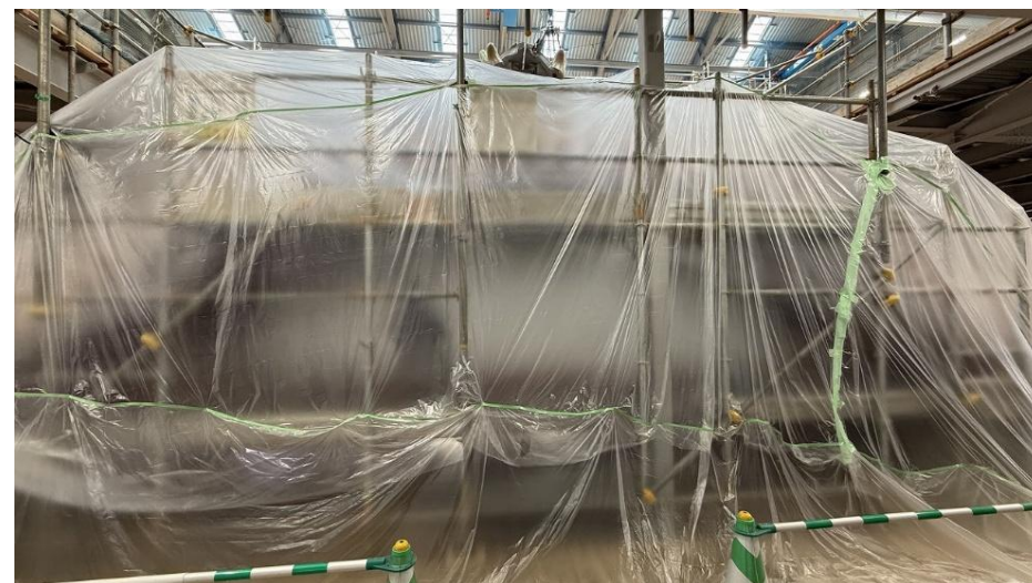
正殿唐破風妻飾(からはふつまかざり) 設置中 2F 西側から東側望む (R7 4/21)
