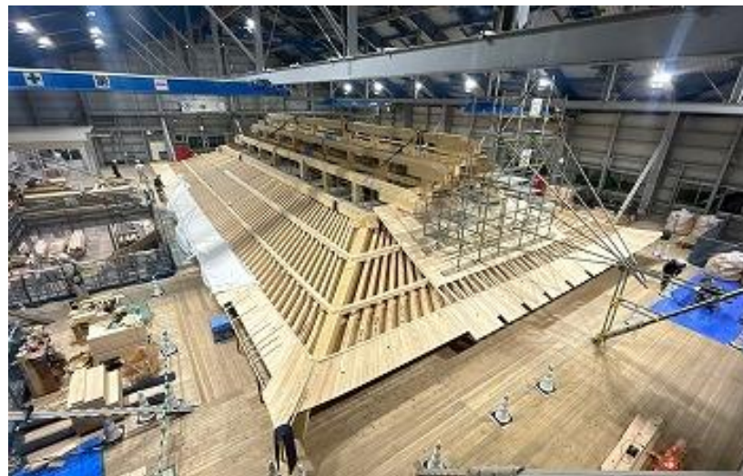
正殿 木工事 上層(母屋、切裏甲建込中) 点検通路 南側から北側望む (R6 3/28)
