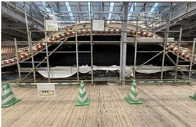
正殿 唐玻豊(からはふう)隅棟 熨斗 瓦積み施工中 2F 西側から東側望む (R7 3/25)
