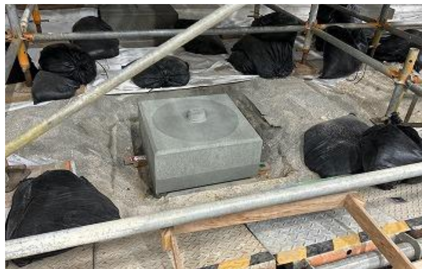
正殿 向拝礎石据付 （R5 10/12）
