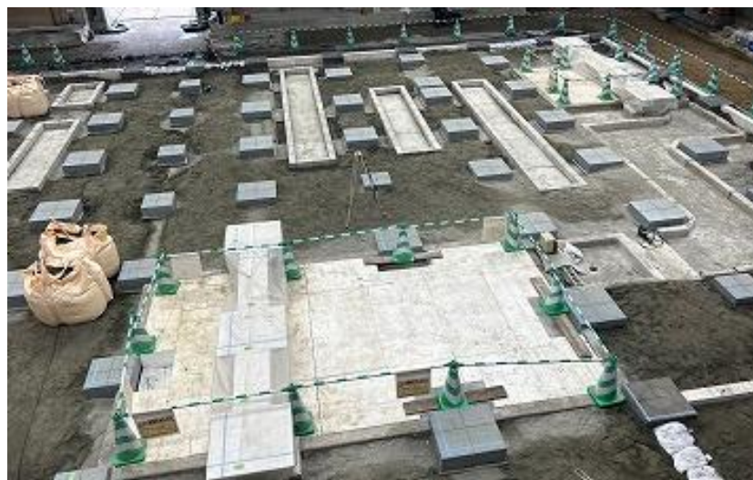
正殿遺構 まわり礎石設置完了(R5 8/8)
