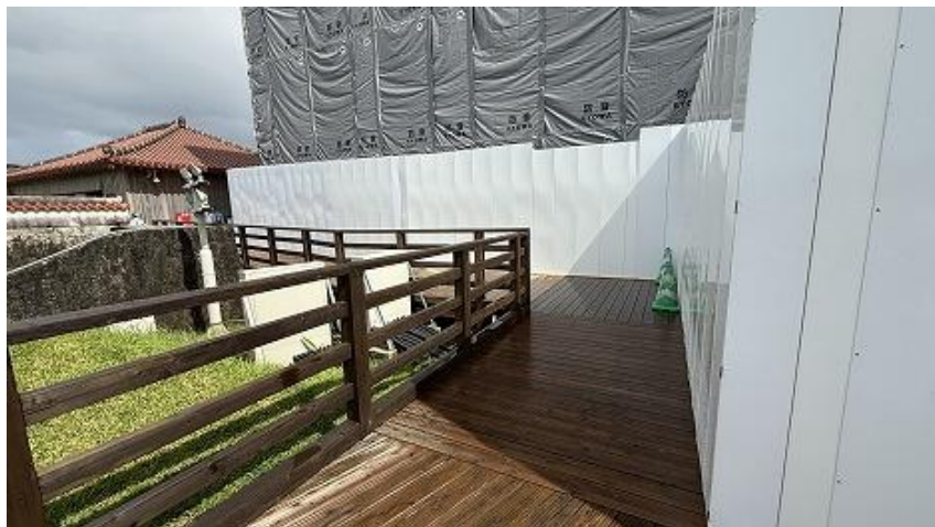
素屋根(北側) 木製見学デッキ施工完了 (R7 6/25)
