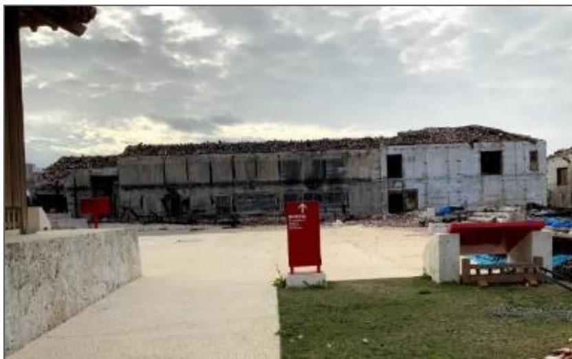
黄金御殿・寄満 解体着手前 (R1 12/28)
