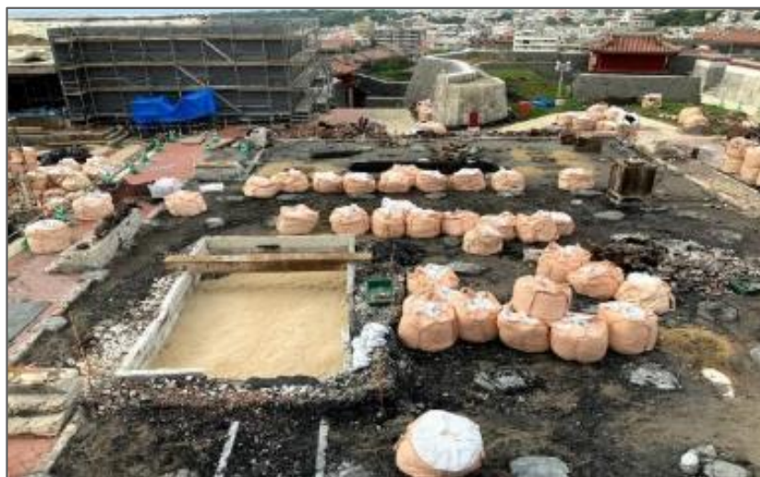
正殿 破損瓦等撤去 作業中 (R2 3/14)
