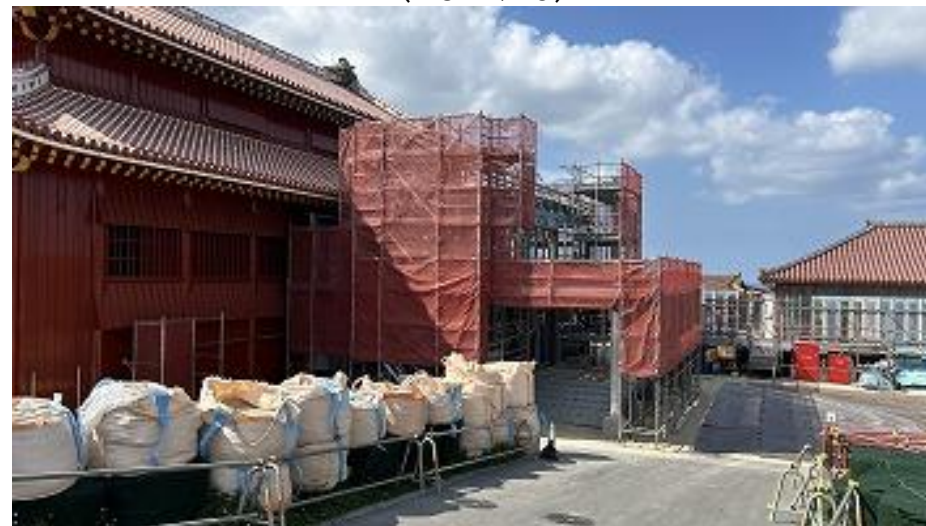
正殿 仮設階段棟 AW枠等取付中 (R8 3/18)
