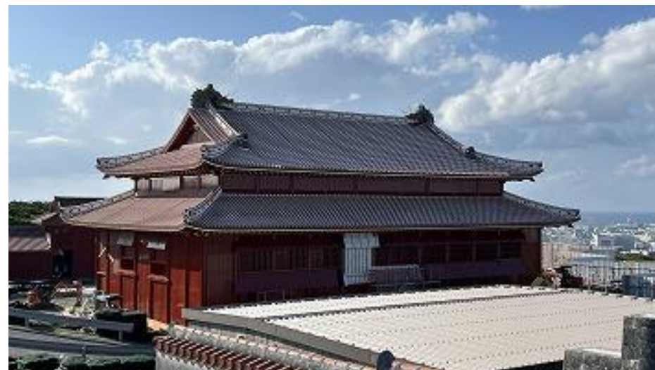
正殿 東側 素屋根基礎等解体中 (R7 10/29)
