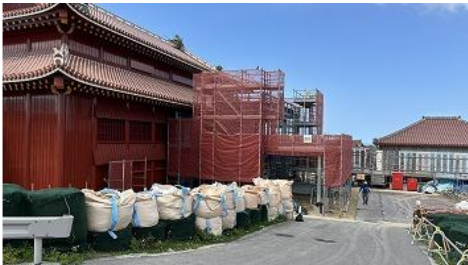
正殿 仮設階段棟 腰壁型枠中 (R8 2/26)
