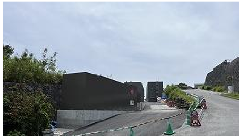
ゲートボックス(東)側より望む 防火水槽舗装完了後 (R8 5/1)
