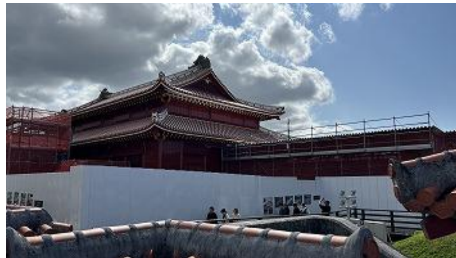
正殿 西之廊下 塗装・瓦工事施工中 (R8 2/26)
