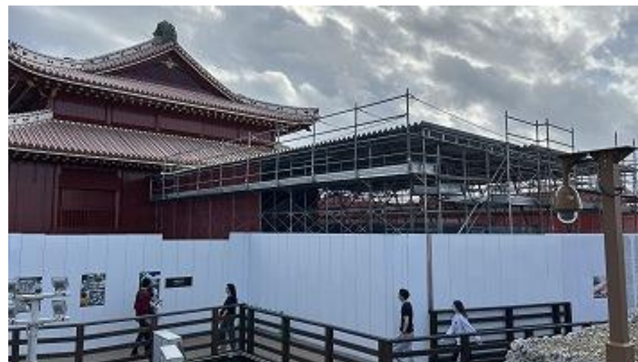
正殿 西之廊下 足場盛替え中 (R7 12/23)
