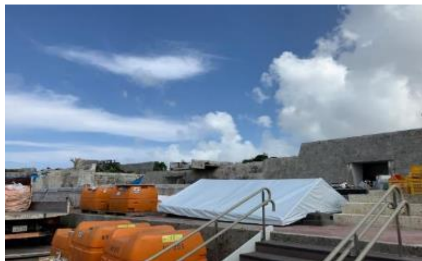
南殿・番所 解体完了 (R2 7/31)
