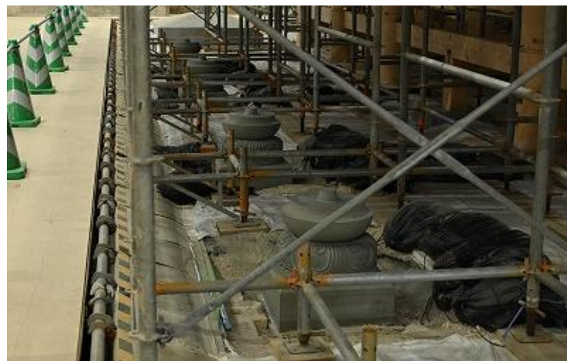
正殿 向拝礎盤据付 （R5 11/21）
