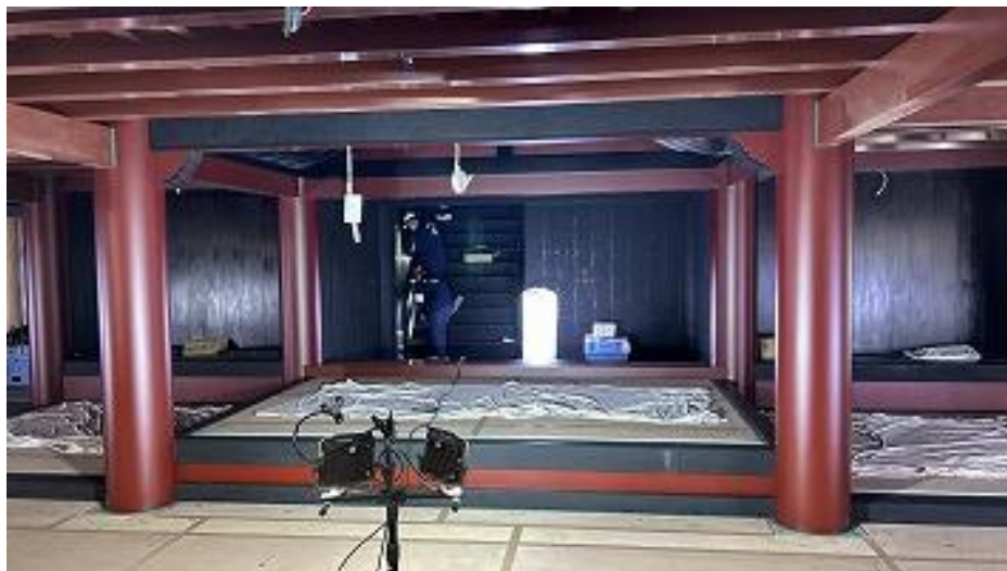
正殿内部 塗装工事 御差床1F 中塗り中 (R8 2/16)
