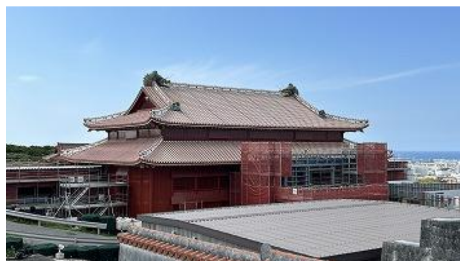
正殿 東側 仮設階段棟 腰壁型枠中 (R8 2/26)
