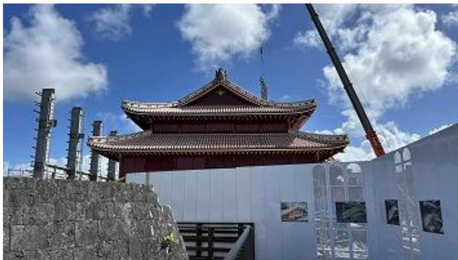
素屋根(北側) 木製見学デッキ供用中 (R7 9/26)
