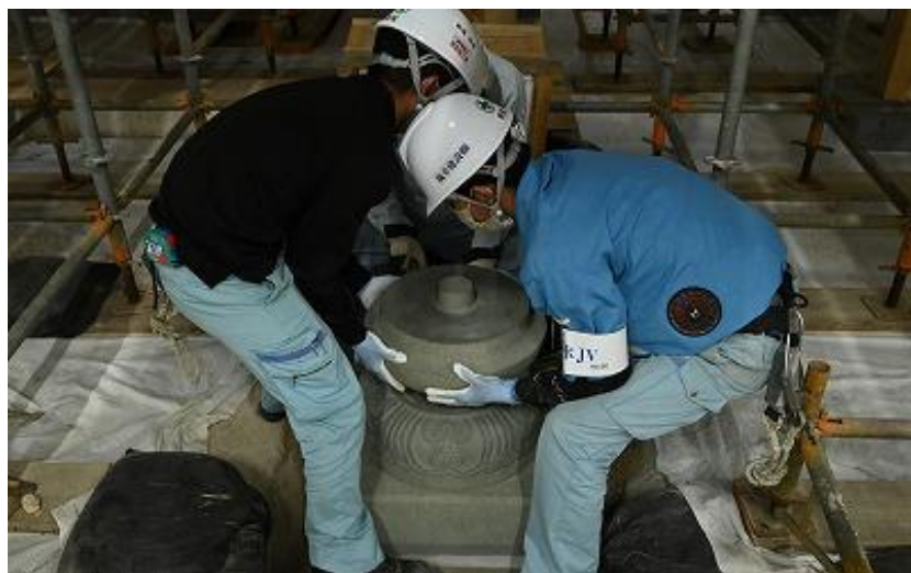
正殿 向拝礎盤据付 （R5 11/21）
