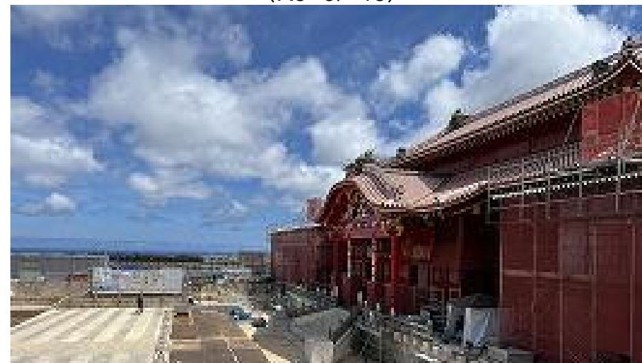
大龍柱 石工事 小龍柱施工完了 (R8 5/21)
