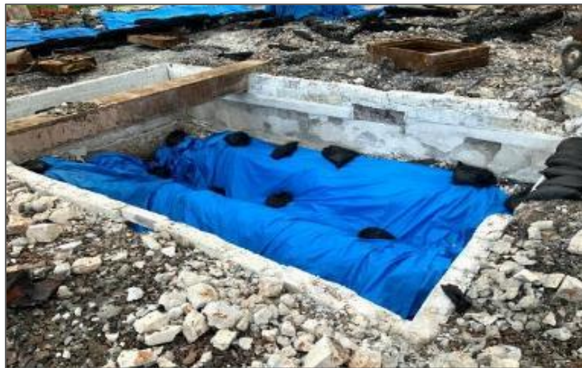
正殿遺構保護 作業着手前 (R2 1/30)
