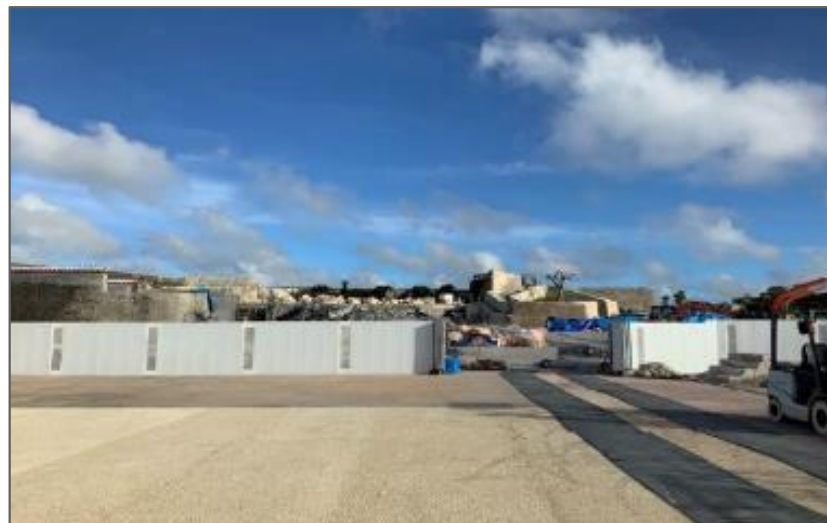
黄金御殿・寄満 解体完了 (R2 6/3)
