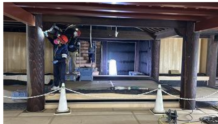
正殿 塗装工事 御差床1F 漆塗り中 (R7 11/17)
