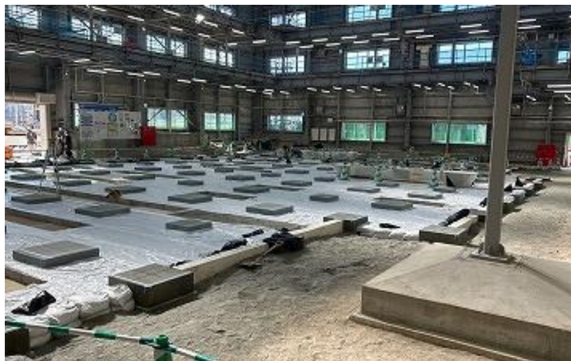
正殿床下 砂上養生シート施工完了 1F (R5 8/23)
