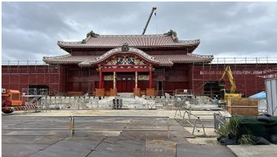
正殿 西側 両廊下、石階段施工中 (R8 1/28)
