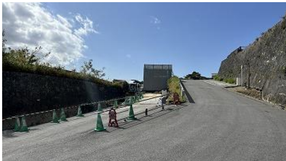
ゲートボックス(東)側より望む 防火水槽床掘中 (R8 1/29)
