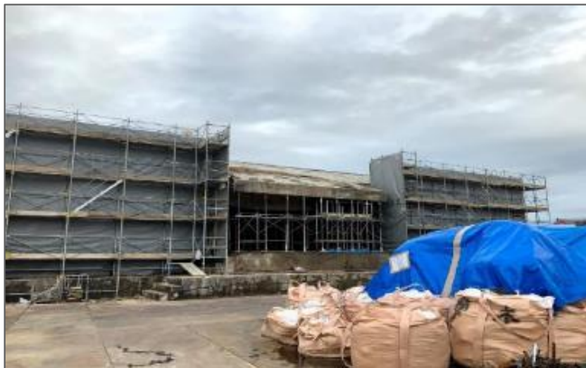
北殿 解体着手前 (R2 3/13)
