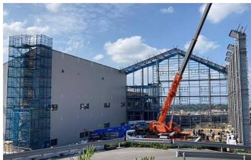
正殿 素屋根(北・東側)鉄骨建方施工中 (R5 3/28)
