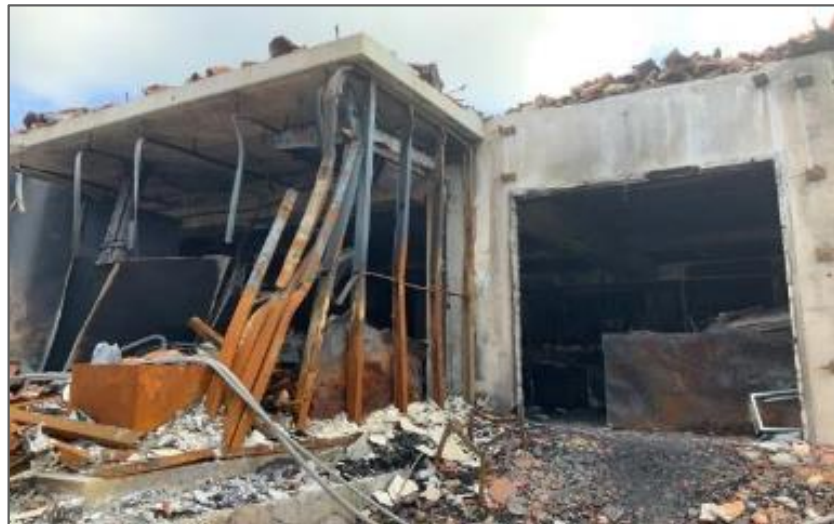
二階御殿 解体着手前 (R2 1/11)
