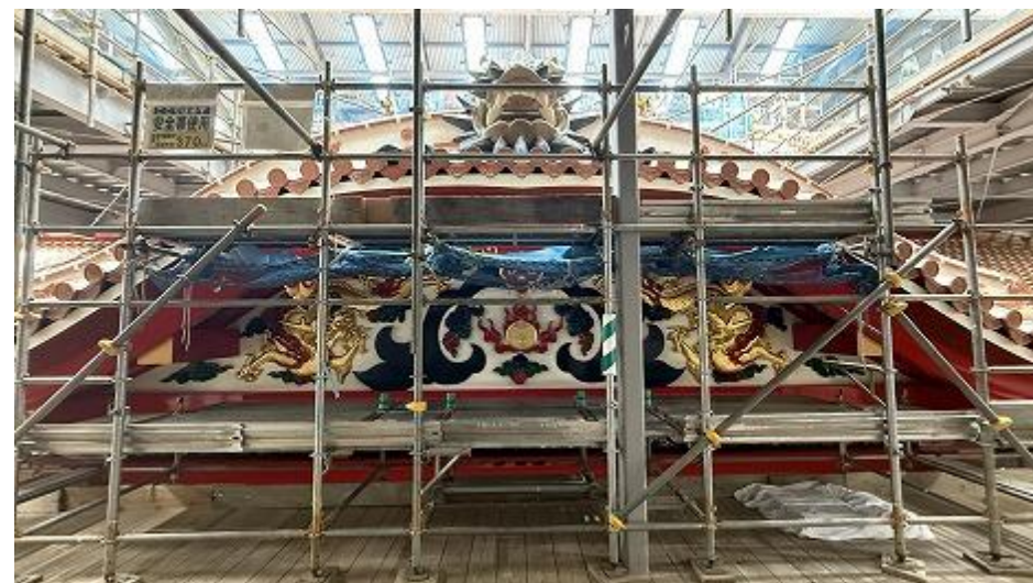
正殿唐玻豊(からはふう)龍頭棟飾り設置中 2F 西側から東側望む (R7 6/25)
