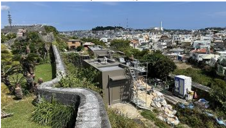
書院鎖之間庭園(南)側より望む 水槽2配管設置中 (R8 2/26)
