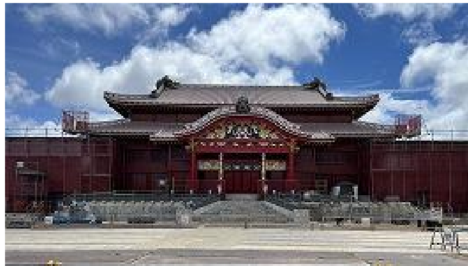
正殿 西側 石階段|高欄施工中 (R8 5/21)
