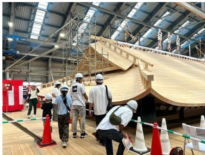
素屋根内(正殿)見学中
