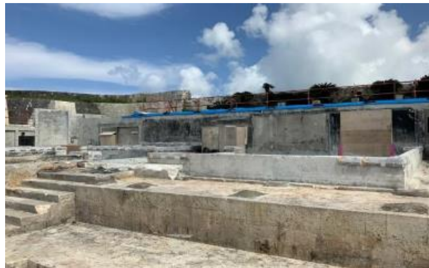
二階御殿 解体完了 (R2 7/31)
