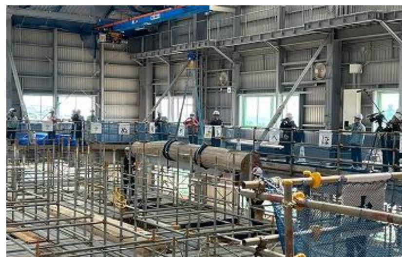
正殿 オキナワウラジログシ 3F 小屋丸太梁建込み (R5 10/27)
