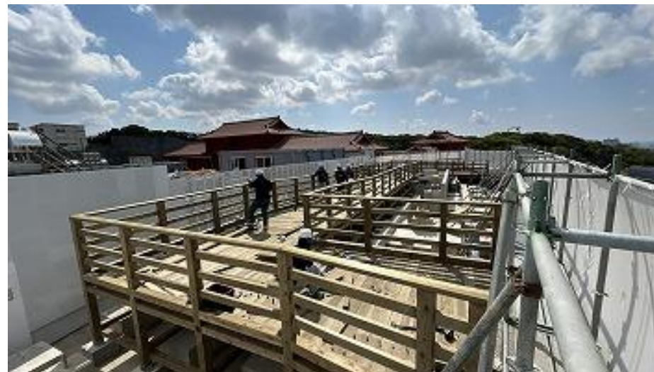
デッキ拡張工事(東側) デッキ設置中 (R8 3/18)
