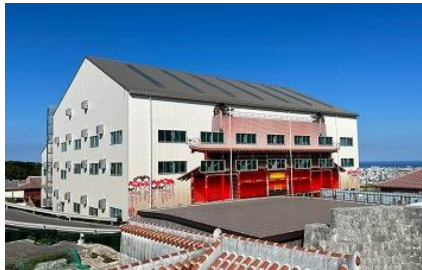
正殿 素屋根東側壁面グラフィック施工 (R5 10/19)
