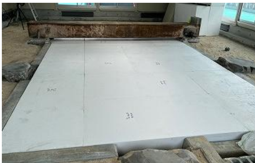
正殿遺構保護 EPS保護施工完了 (R4 7/25)
