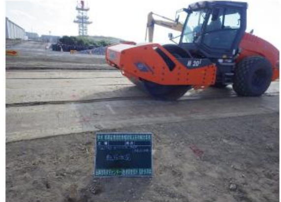
振動ローラーによる転圧試験
