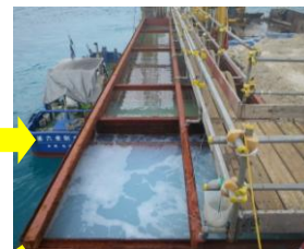
濁水を台船に設置した水槽へ
