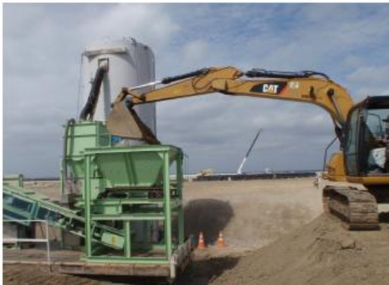
破砕混合機を使用した空港残土の改質状況
