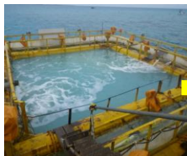
沈殿処理システム水槽運転
