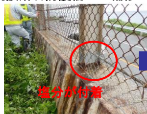
既設落石防護柵の腐食状況
