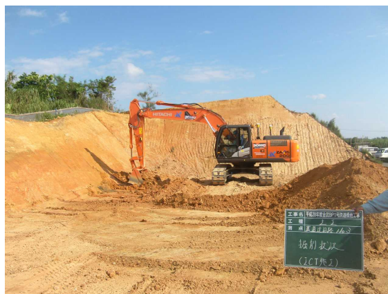
【MCバックホウによる掘削作業】
