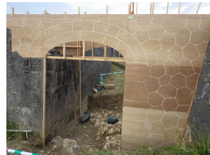
石造拱門 型枠設置
