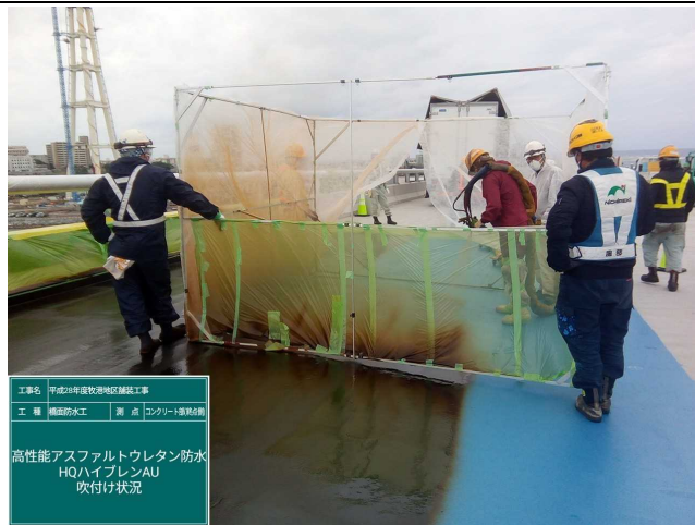
高性能ウレタン防水施工状況
