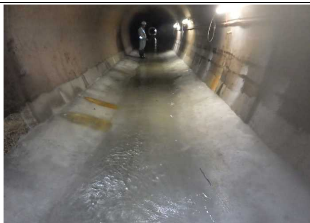
調整水路トンネルインバート補修工完了
