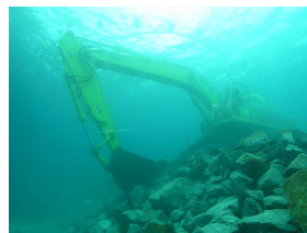
(上) ボックスカルバート据付 (下) 水中バックホウ
