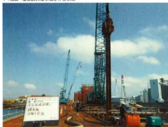
P4橋脚 埋設鋼矢板引き抜き作業状況
