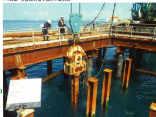
P4橋脚 埋設鋼矢板引き抜き作業状況
