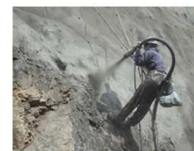
仮設用モルタル吹付状況
