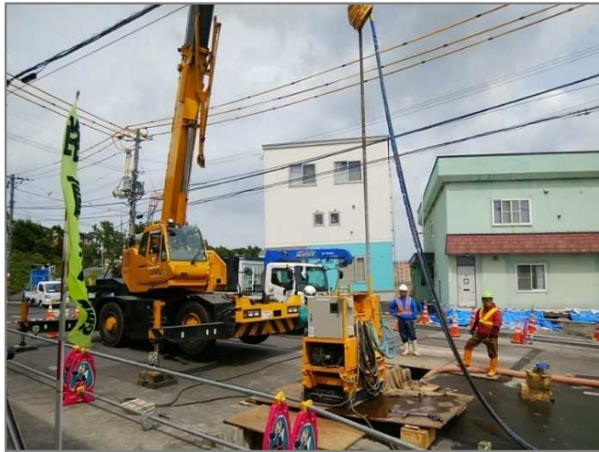
工 種 名：軟弱地盤処理工（高圧噴射攪拌工） 改定概要：二重管工法における適用範囲の拡大
