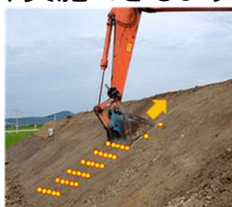
ICTバックホウの刃先等の施工履歴データを記録
