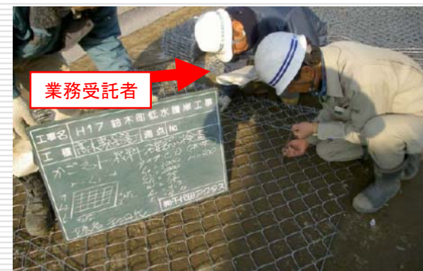
(河川護岸用かごマットの材料確認)
