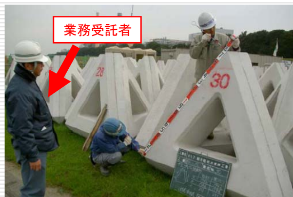
(根固めブロックの材料確認)
