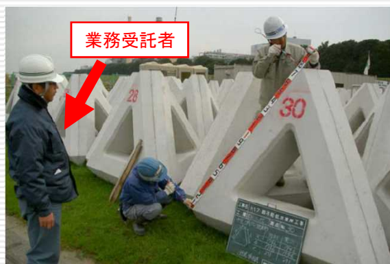
(根固めブロックの材料確認)
