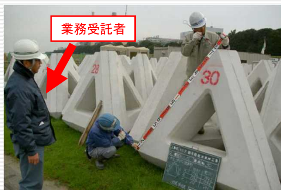
(根固めブロックの材料確認)
