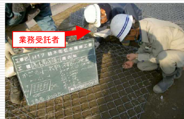
(河川護岸用かごマットの材料確認)
