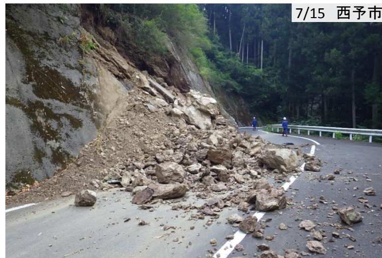
大雨によって崩落した斜面を調査
