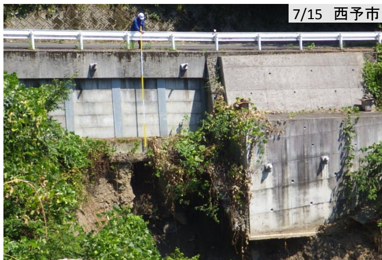
大雨によって崩落した擁壁下の斜面を調査
