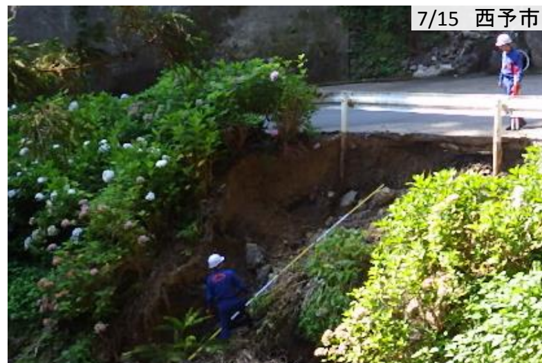
大雨によって崩落した斜面を調査
