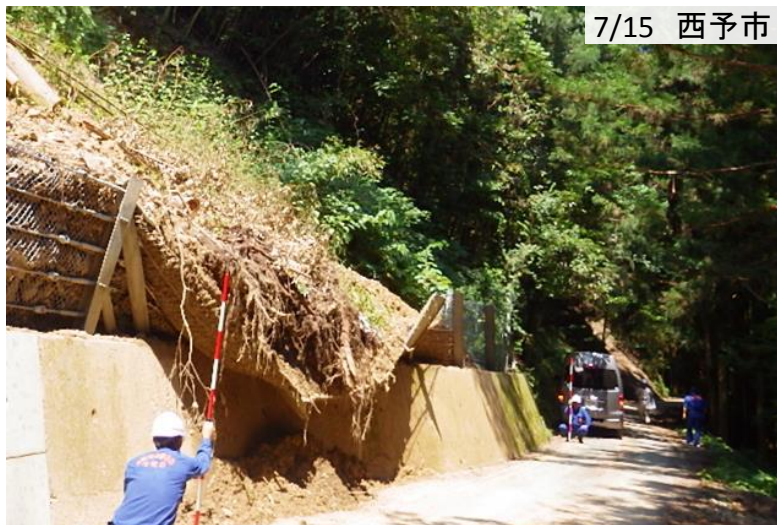
大雨によって崩落した斜面を調査
