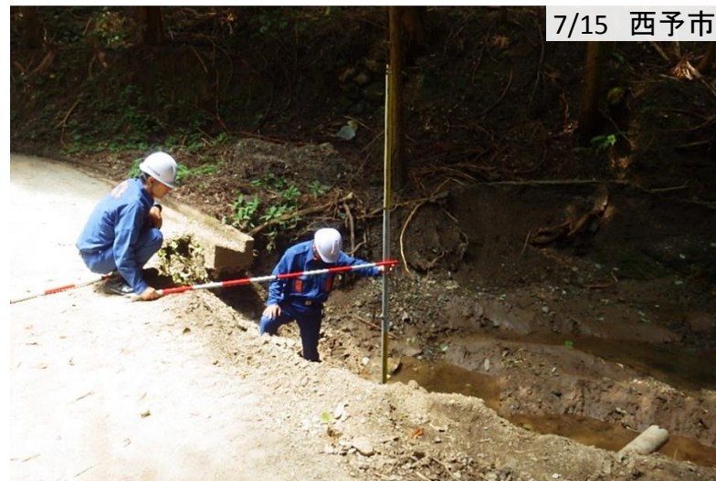
大雨によって崩落した道路を調査
