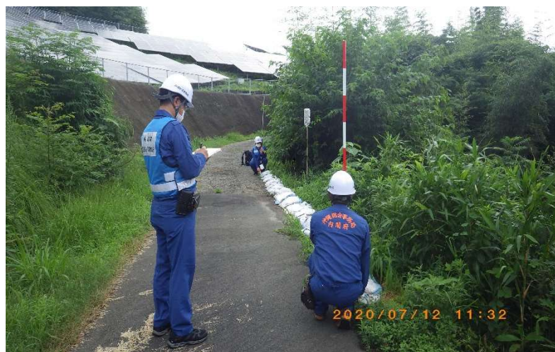
【被災状況調査(相良村)】
