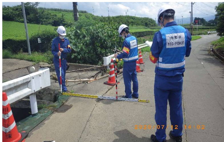
【被災状況調査(相良村)】
