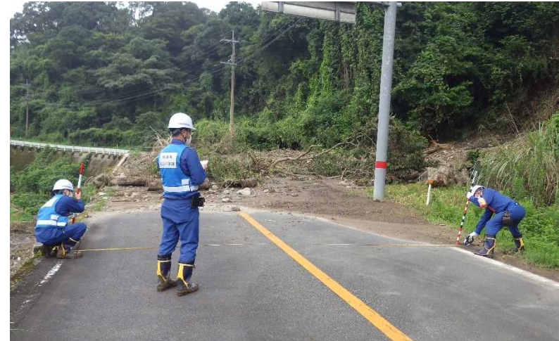
【被災状況調査(相良村)】
