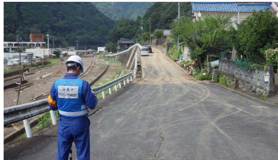
【被災状況調査(八代市)】
