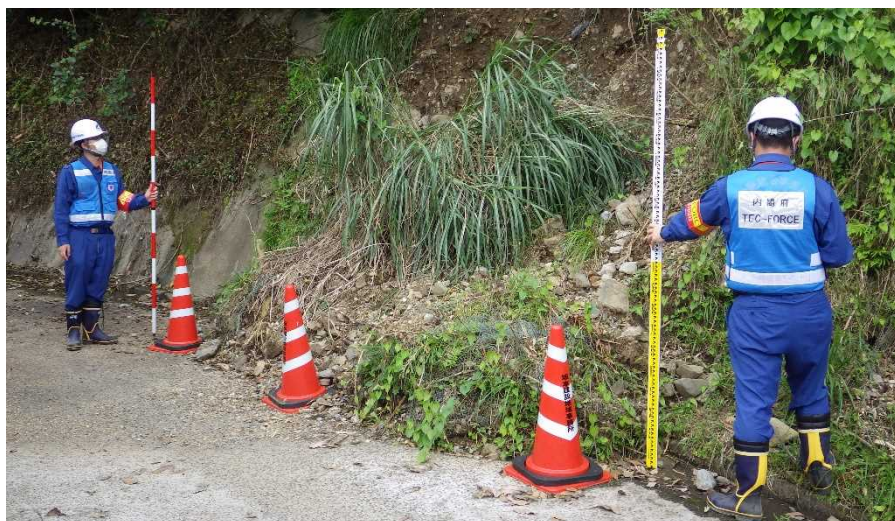
【被災状況調査(八代市)】
