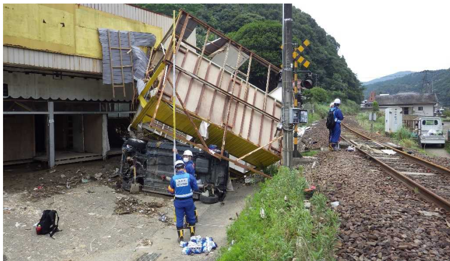
【被災状況調査(八代市)】
