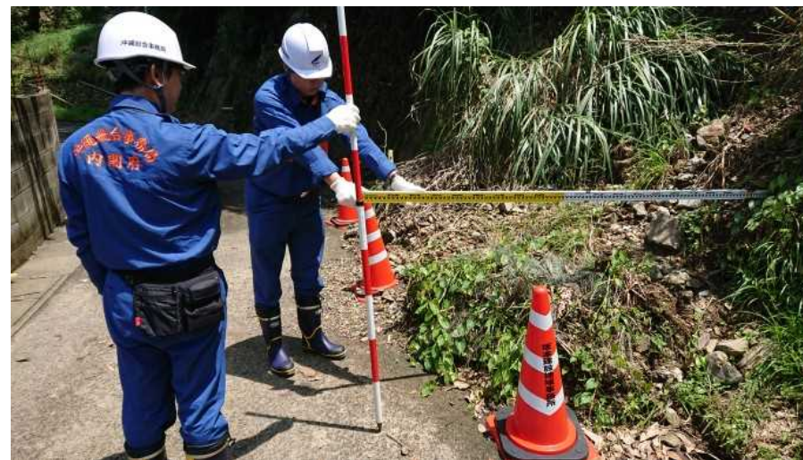
【被災状況調査:道路脇法面の崩落状況(八代市)】
