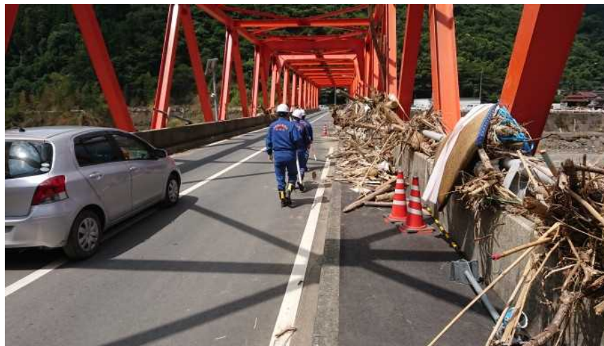
【被災状況調査:流木等による通行阻害状況】
