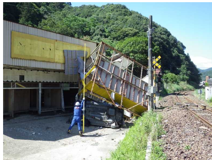
【被災状況調査:家屋倒壊状況(八代市)】
