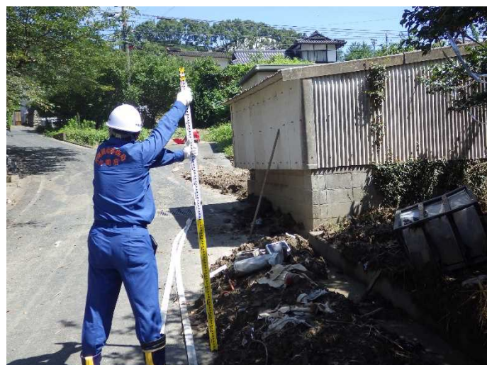
【被災状況調査:土砂等体積状況(八代市)】
