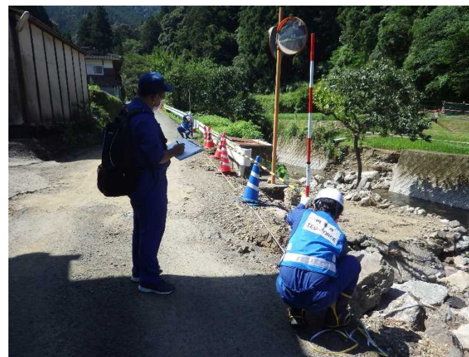
【被災状況調査:護岸崩落状況(八代市)】
