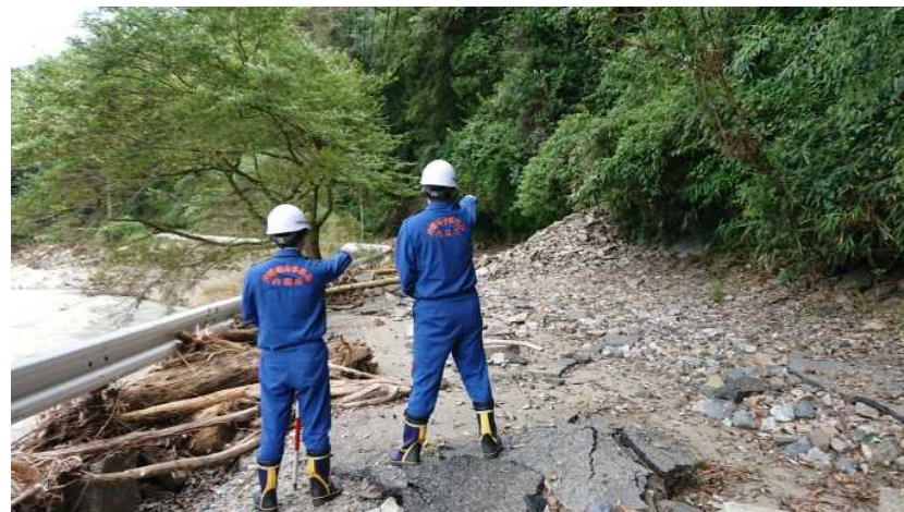
【被災状況調査:土砂流出状況(相良村)】
