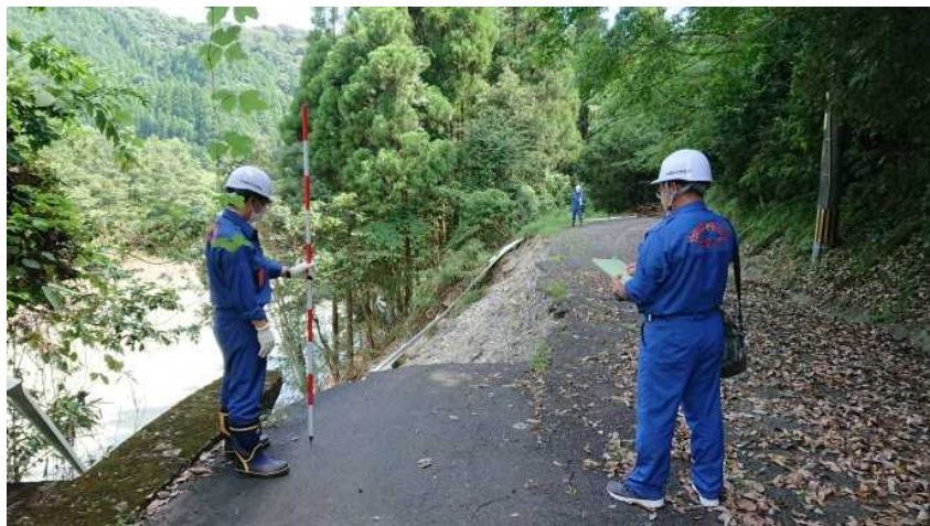
【被災状況調査:護岸崩壊状況(相良村)】
