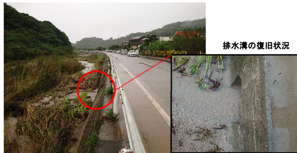
村道等の土砂撤去作業完了による排水溝の機能復旧を確認
