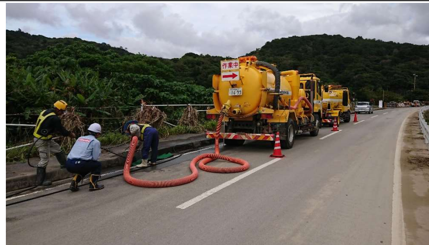
排水管清掃車での土砂撤去支援
