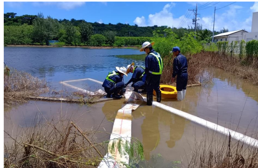
冠水箇所の吸い込み口、設置
