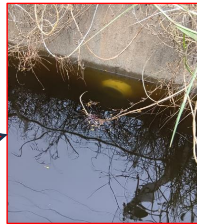
水没した浄化槽排水口の状況
