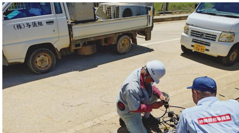
小型ポンプを貸与するため電源プラグの変換作業を実施(協力会社：(株)与儀組)
