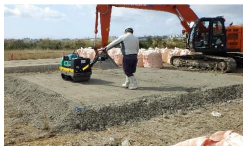
試験体の敷均し・転圧の様子
