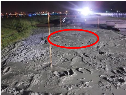
埋戻し (碎石による埋戻し)
