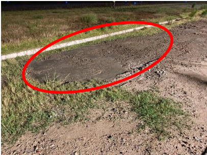
埋戻し (碎石による埋戻し)
