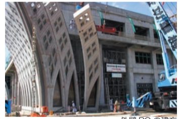
外壁PCの建方
