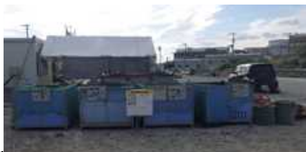
回収用コンテナの設置状況
