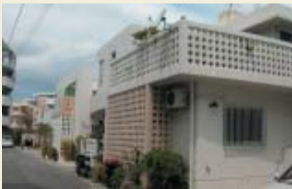
コンクリート住宅の普及による陸屋根化
