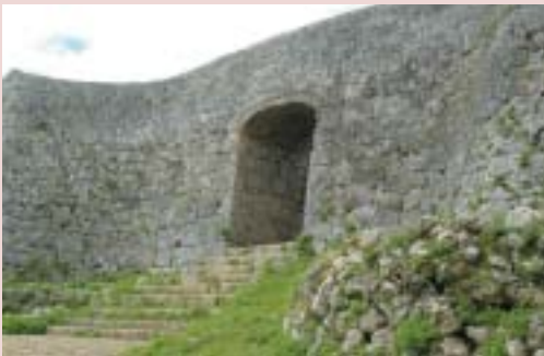
布積み以外にも野積み、あいかた積みが採用されている中城城跡(中城村)
