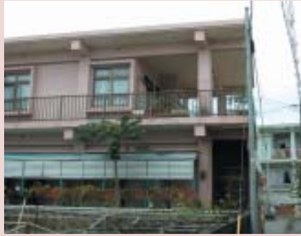
多くの地域で見られるコンクリート住宅
