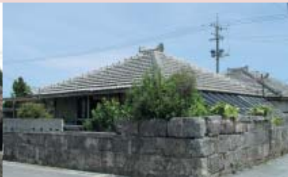
セメント瓦(久米島町鳥島)
