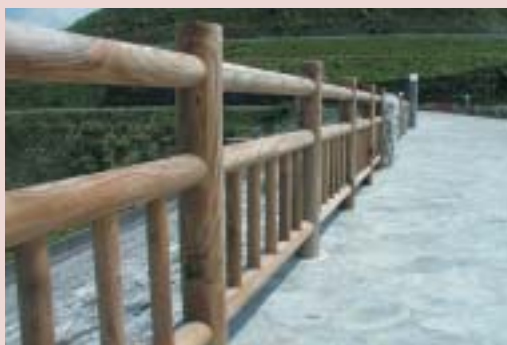
ダム堤体に使われている木柵(名護市羽地ダム)
