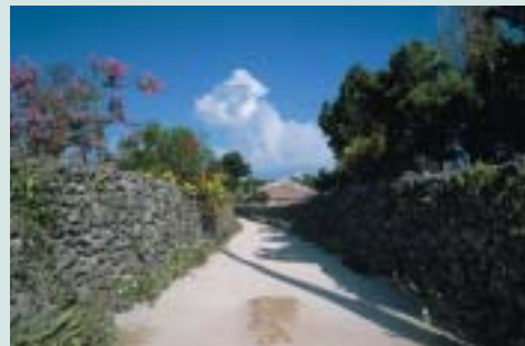
サンゴ石など地域で採れる石材を活用した石垣（竹富町）
