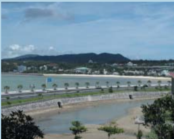
国道58号沿いの長虹堤をイメージした歩道(恩納村仲泊)
