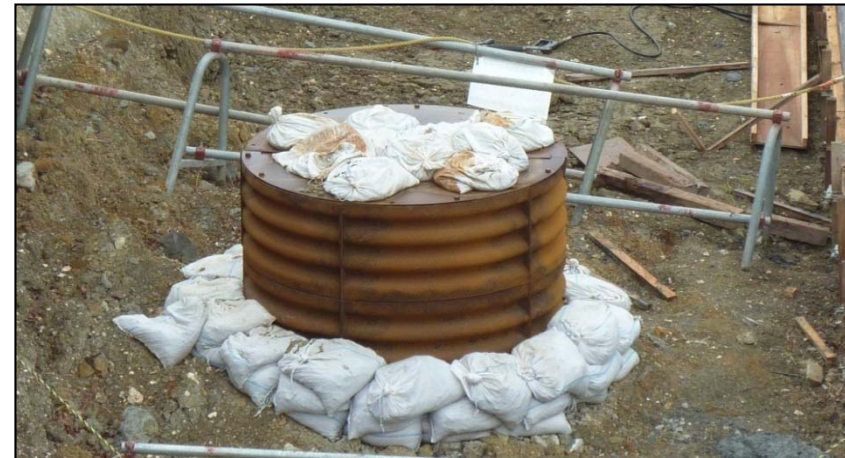
【小型ライナープレートの使用状況】
