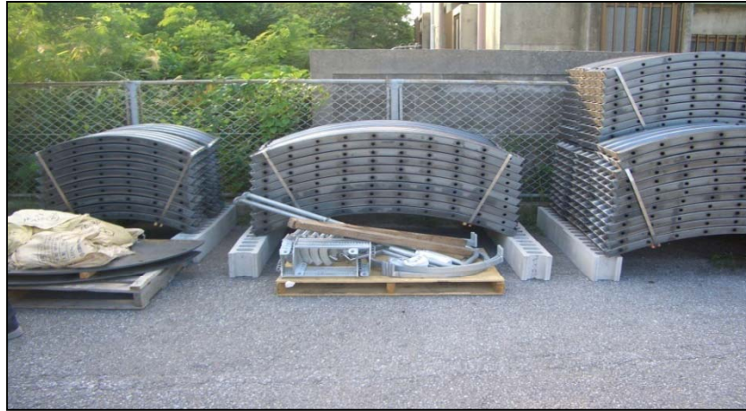
【ライナープレート解体状況(左:小型、中央・右:大型)】
