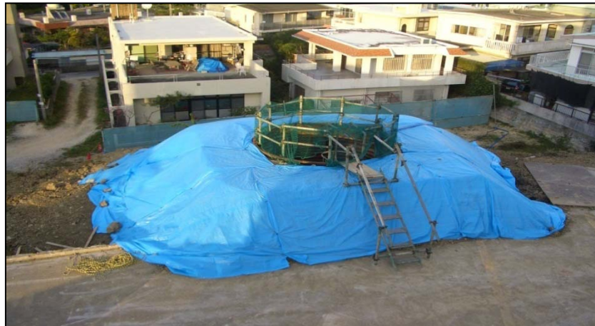
【大型ライナープレートの使用状況】
