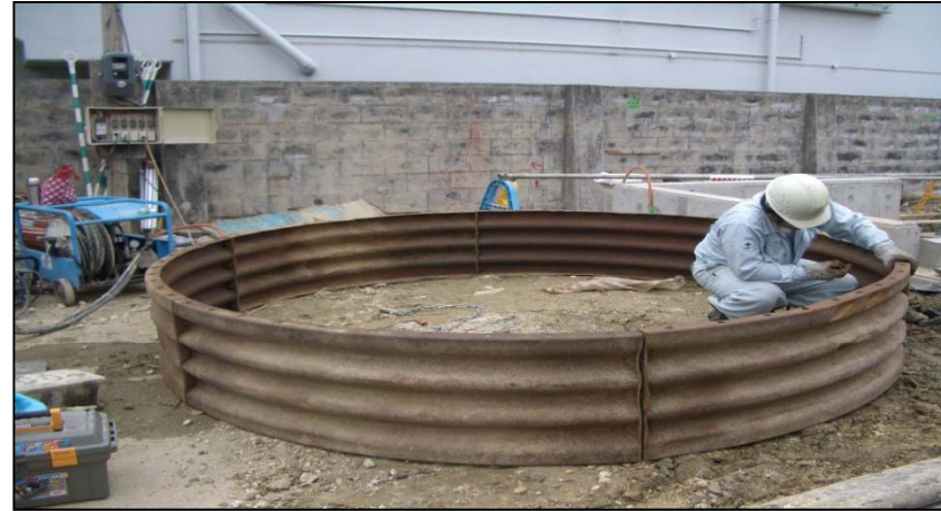
【大型ライナープレート設置状況】
