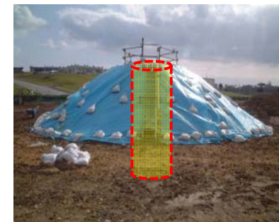
大型ライナープレート設置状況
