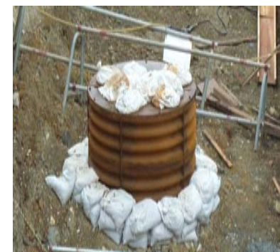
小型ライナープレート設置状況
