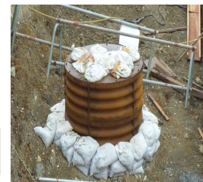
小型ライナープレート設置状況
