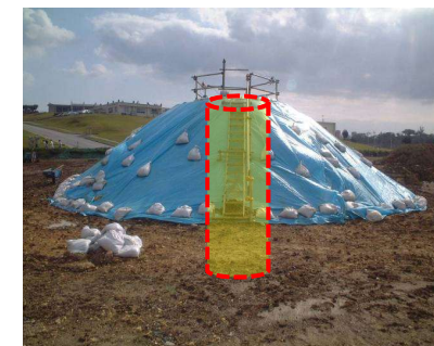
大型ライナープレート設置状況
