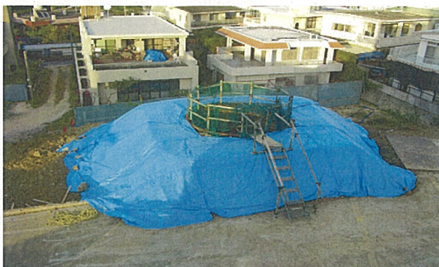
【大型ライナープレートの使用状況】
