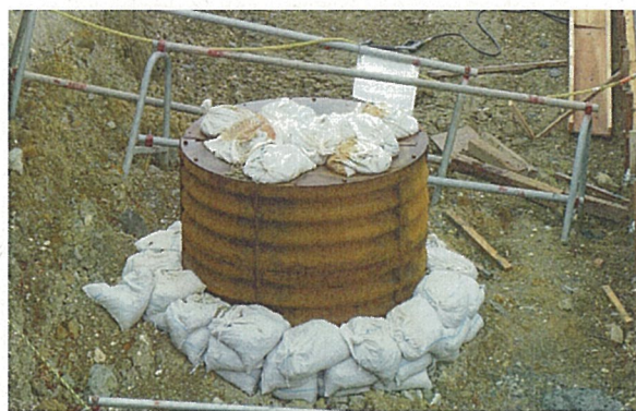
【小型ライナープレートの使用状況】
