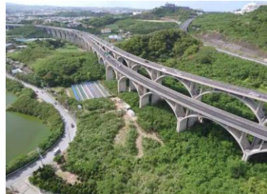
▲国道506号南風原アーチ橋
