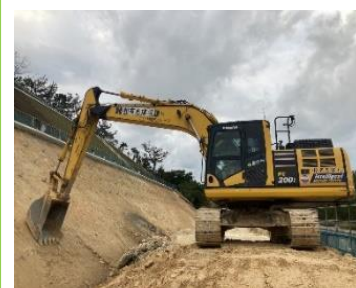
▲ICT 土工施工状況
