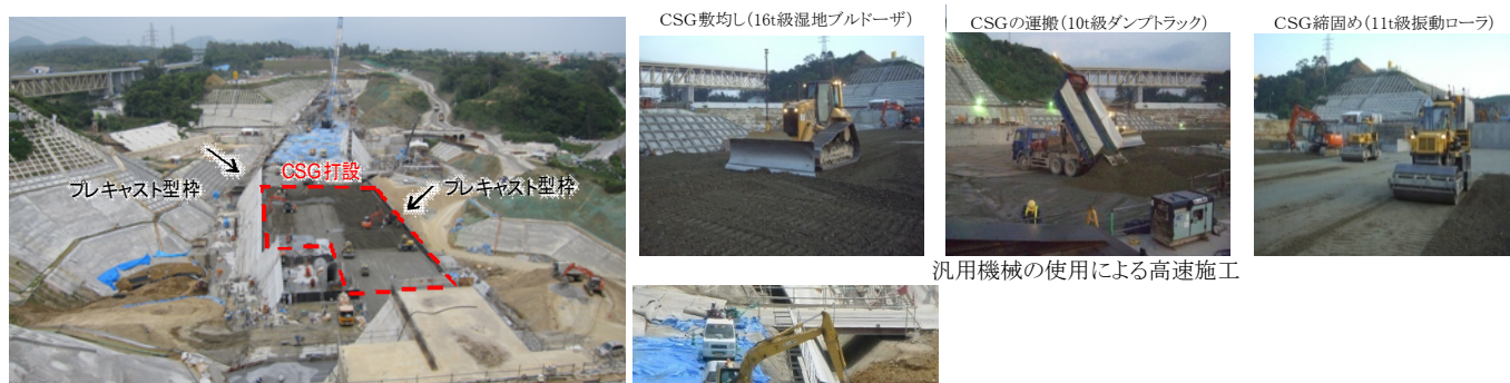
重力式コンクリートダムと台形CSGダムの工期比較
