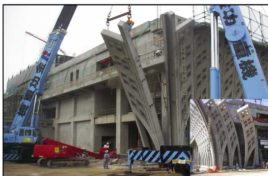
現場で作成した3次元のプレストレストコンクリート壁の立て込み状況
