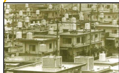
給水制限時の自衛手段の屋上タンク
