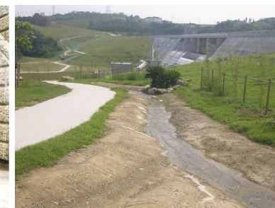
金武ダム魚道
