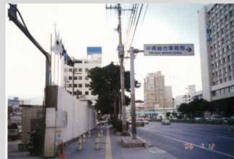
電線共同溝事業：那覇市（一般国道58号）
