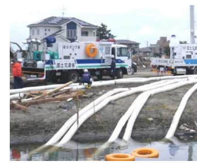
排水ポンプ車による活動状況
