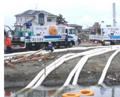
排水ポンプ車による活動状況
