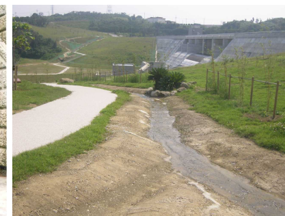
金武ダム魚道
