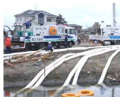
排水ポンプ車による活動状況
