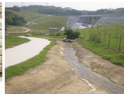
金武ダム魚道
