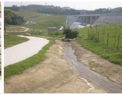
金武ダム魚道
