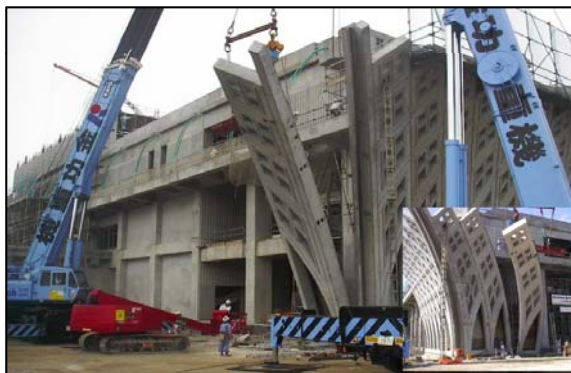
現場で作成した3次元のプレストレストコンクリート壁の立て込み状況
