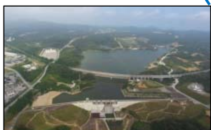
10ダム目となる金武ダムの竣工(H25年度末)
