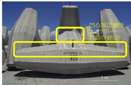
凹凸 processed block to reduce wave 消波ブロックの加工(那覇港)
