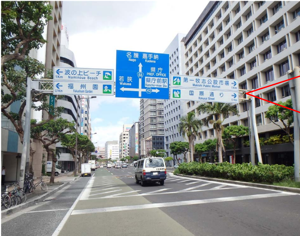
国道58号 那覇市久茂地
