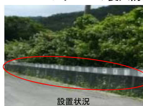
環境保全対策の一環として、県と連携してS-Fラインにヤンバルの森へのマングースの侵入を防除するフェンスを整備。
