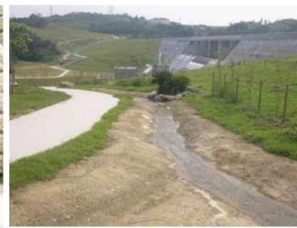
金武ダム魚道
