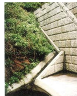
漢那ダム魚道
