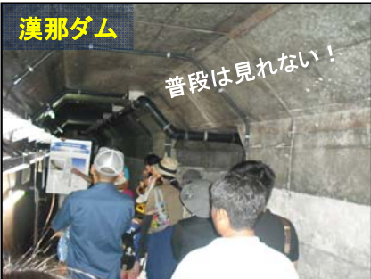
ダム堤体見学
